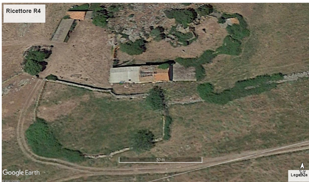
Figura 2 Ricettore R4, particolare con tetto crollato, presenza di alberature di alto fusto che schermano l'edificio
