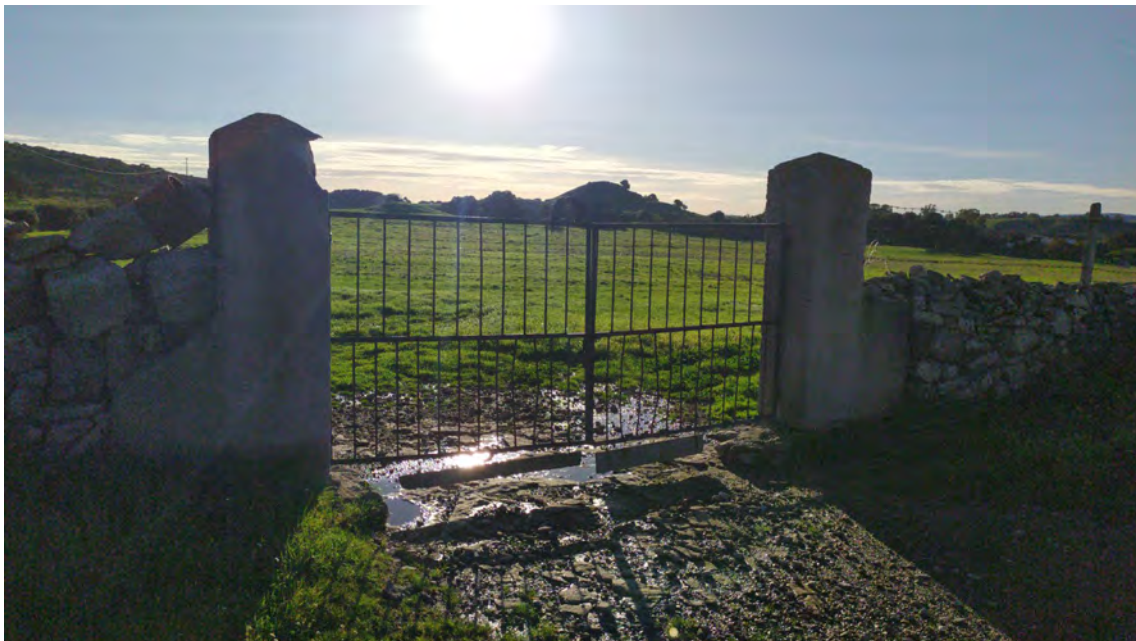
STATO DI FATTO- accesso privato chiuso con cancello non accessibile
