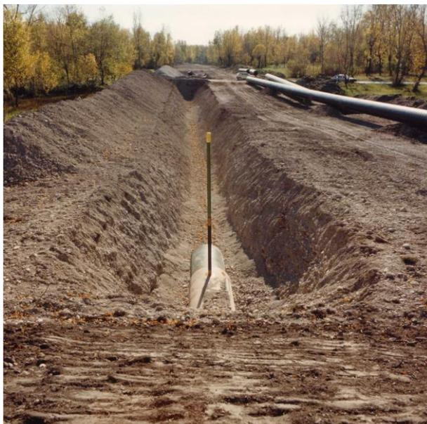
**Fig. 7.1.H - Attraversamento con tubo di protezione, particolare dello sfiato**
