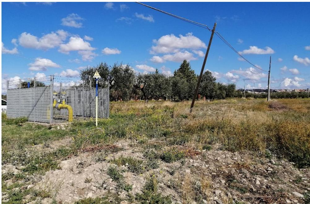
*Fig. 7.1.K – Esempio di Punto di Intercettazione di Linea (PIL)*
