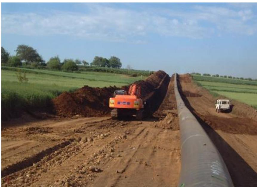
*Fig. 7.1.D – Foto tipica di scavo della trincea*
