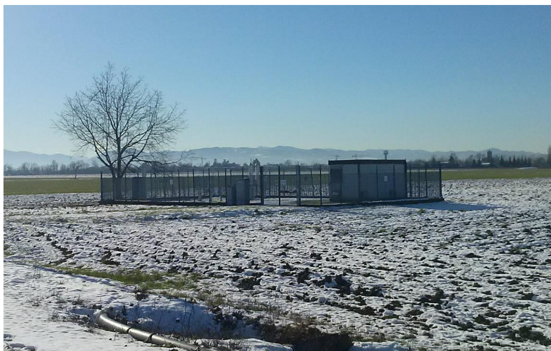
Figura 5-21 – Esempio di impianto al termine dei lavori
