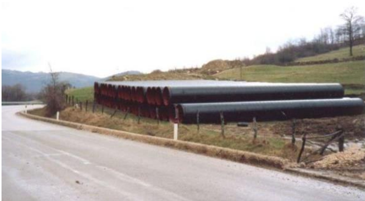
Figura 5-1 – Piazzola di accatastamento tubazioni
