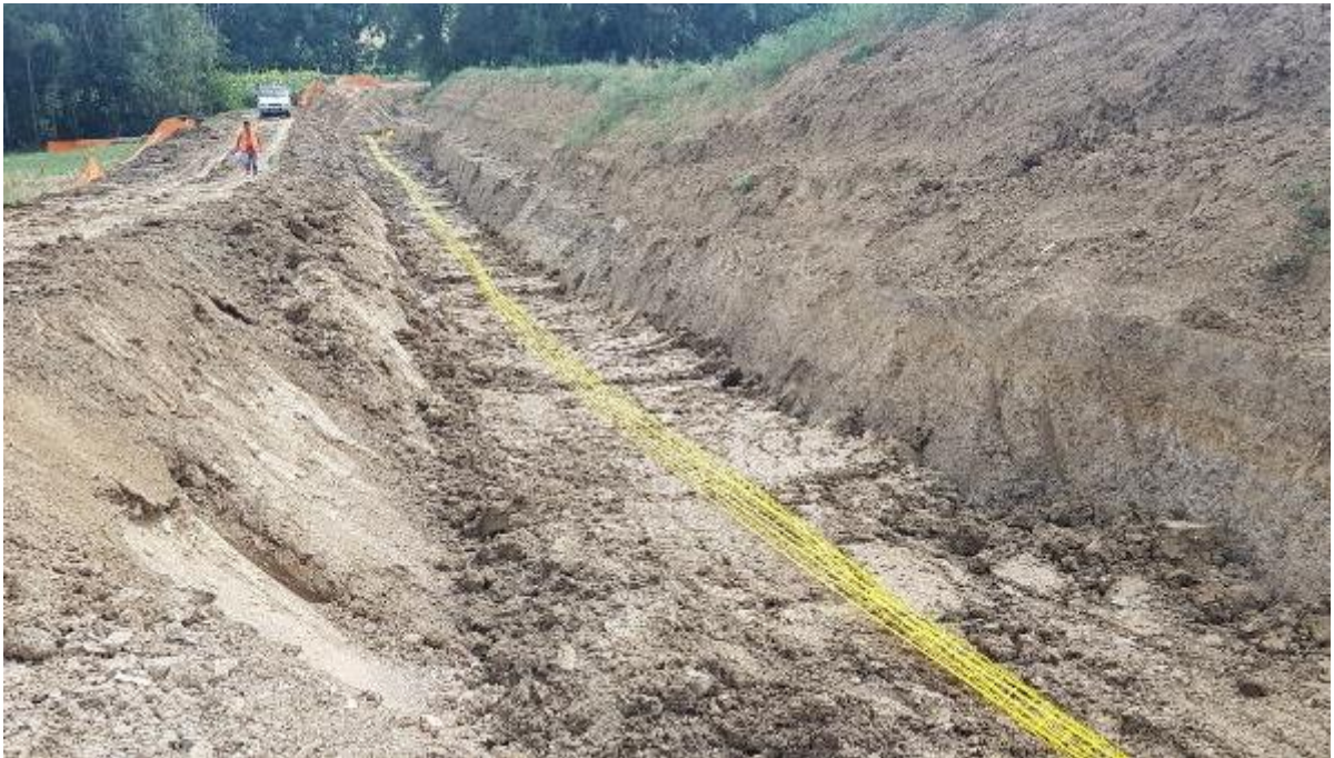
Figura 5-12 – Rinterro della condotta
