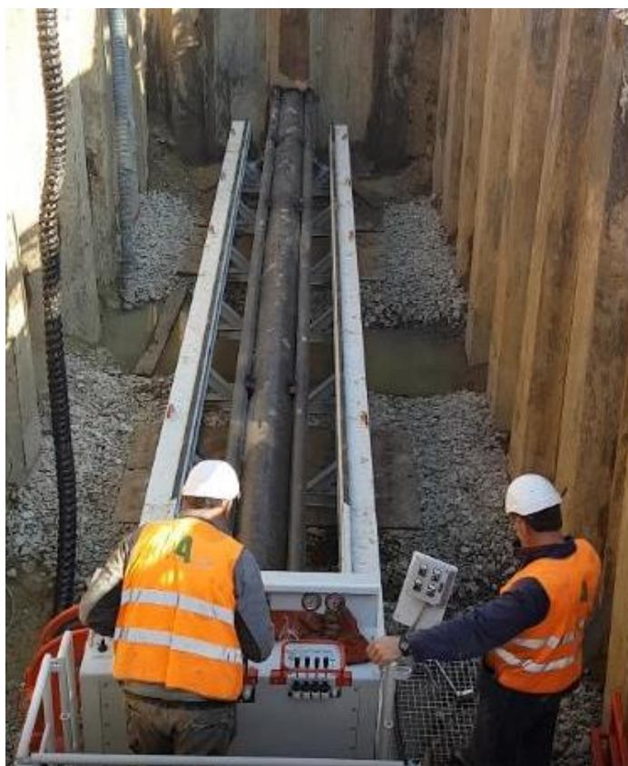
Figura 5-16 – Esecuzione di trivellazione spingitubo
