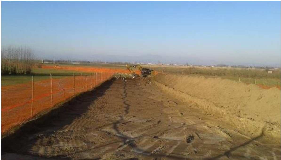
Figura 5-2 – Foto di apertura della pista di lavoro
