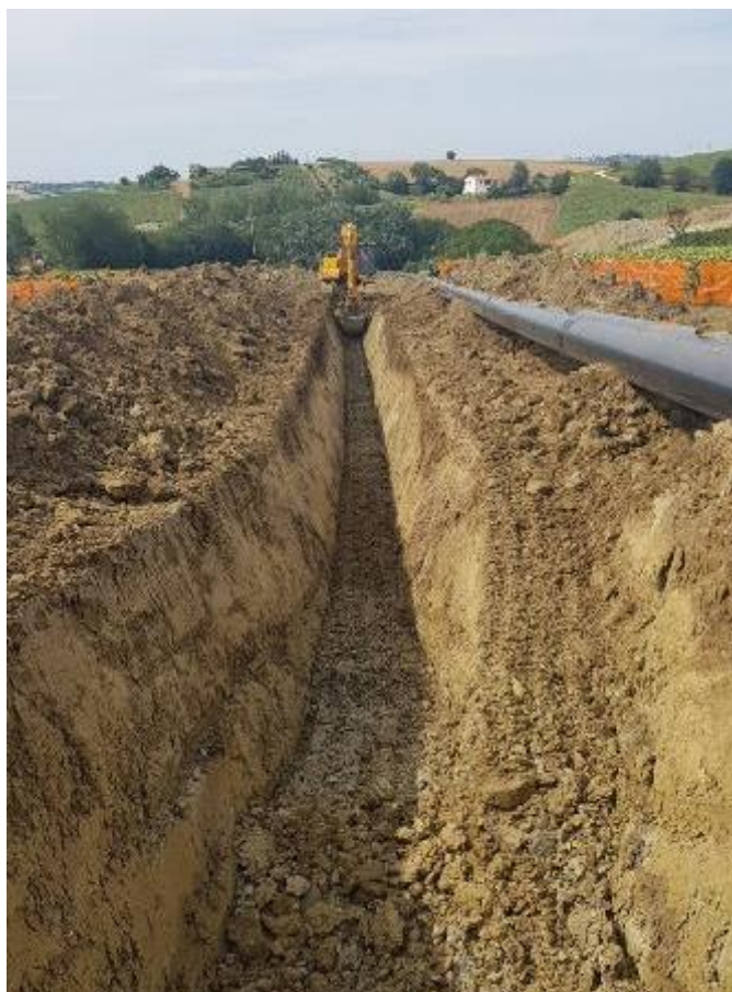
Figura 5-9 – Scavo della trincea
