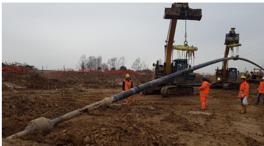
Figura 5-20 – Esempio di operazione di varo della TOC
