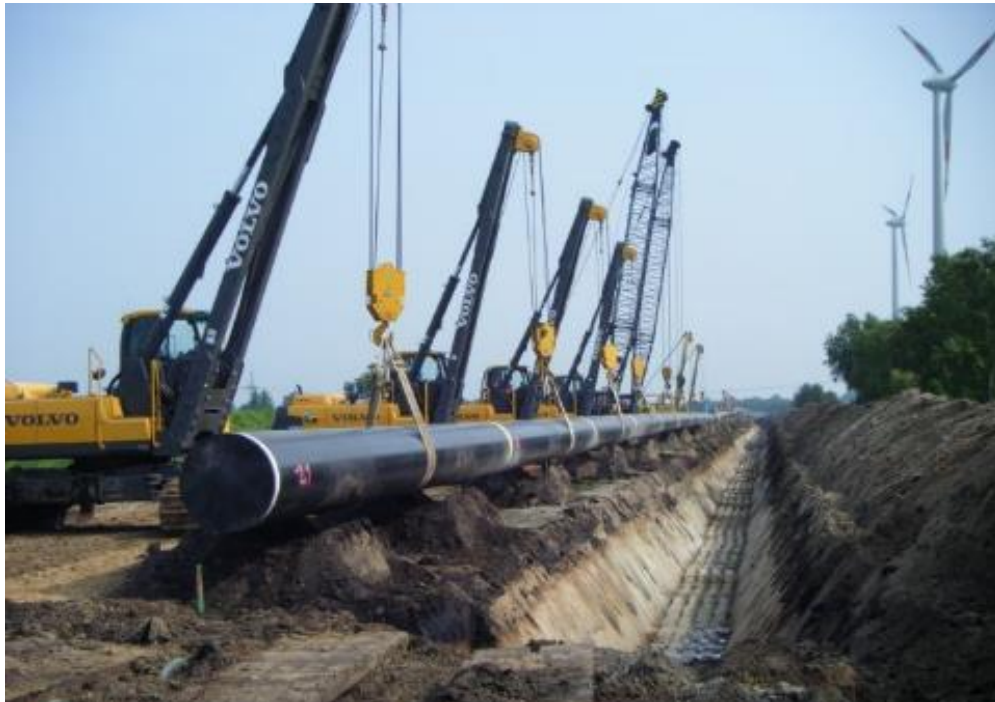
Figura 5-11 – Posa della condotta
