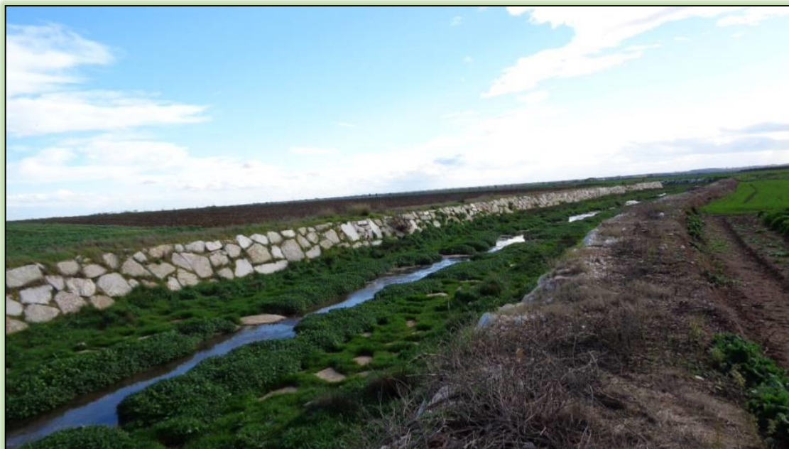
Figura 2-50 - Canale con argini artificializzato (scogliera) attraversato dal progetto in Loc. C. Galassi ad Apricena. Si nota una densa vegetazione di sedano d’acqua ( Apium nodiflorum ) e un deflusso idrico discreto con poco sedimento in sospensione (acque trasparenti).
