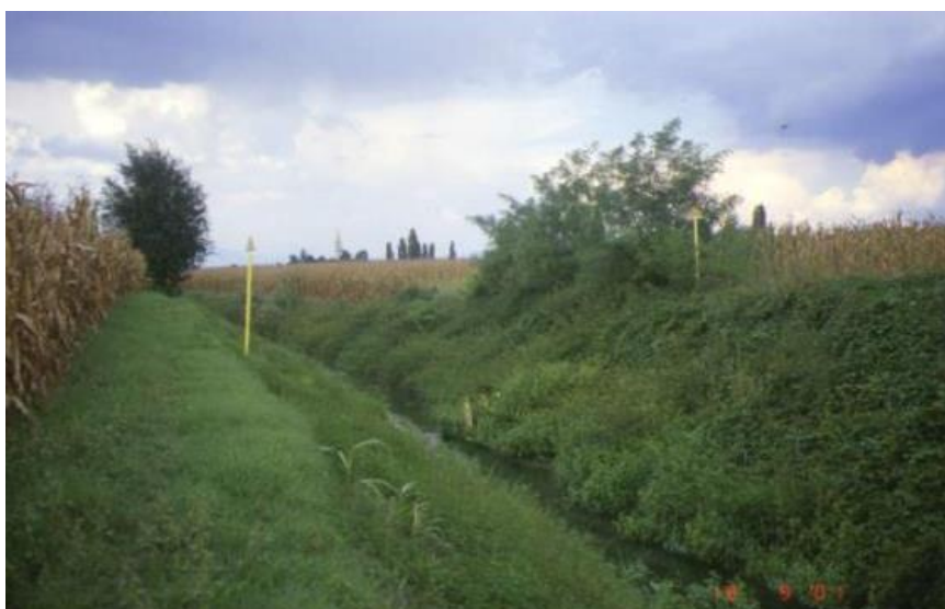
Figura 5-22 – Esempio di opera ultimata in corrispondenza di attraversamento di corso d'acqua in ambito agricolo
