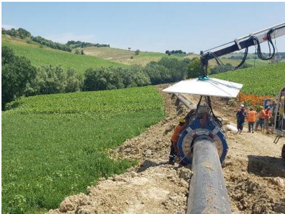
Figura 5-8 – Esempio di saldatura automatica
