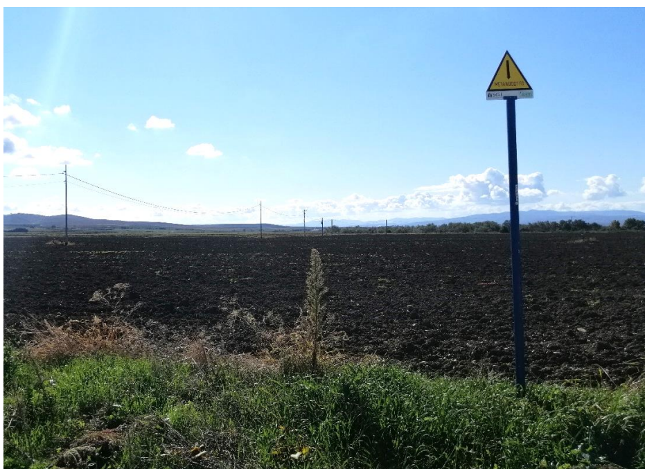
Figura 6-1 – Pista lavori, su terreno agricolo, a ripristini ultimati; si nota la disposizione delle paline segnaletiche su gasdotto in esercizio
