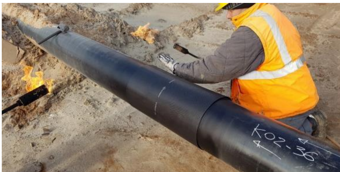
Figura 5-10 – Applicazione manuale di una fascia termorestringente su giunto di saldatura
