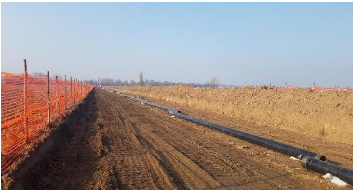
Figura 5-6 – Sfilamento delle tubazioni di linea
