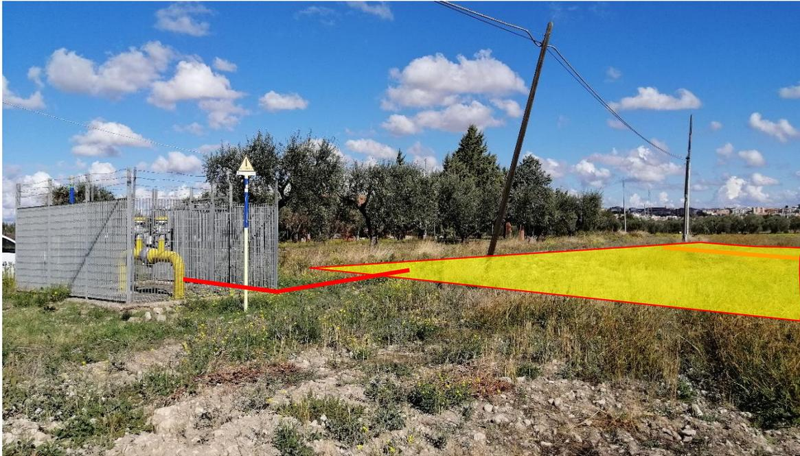
Foto n. 1 – Area Impianto n.0 (PIDI – SKID REG. – L/R) con stacco a monte dell’impianto PIL “VA2” del Met. Reggente – Chieuti DN200 da modificare e inglobare all’interno della nuova area impianto n.0
