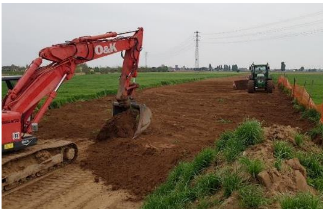
Figura 2-6 – Rinterro della condotta
