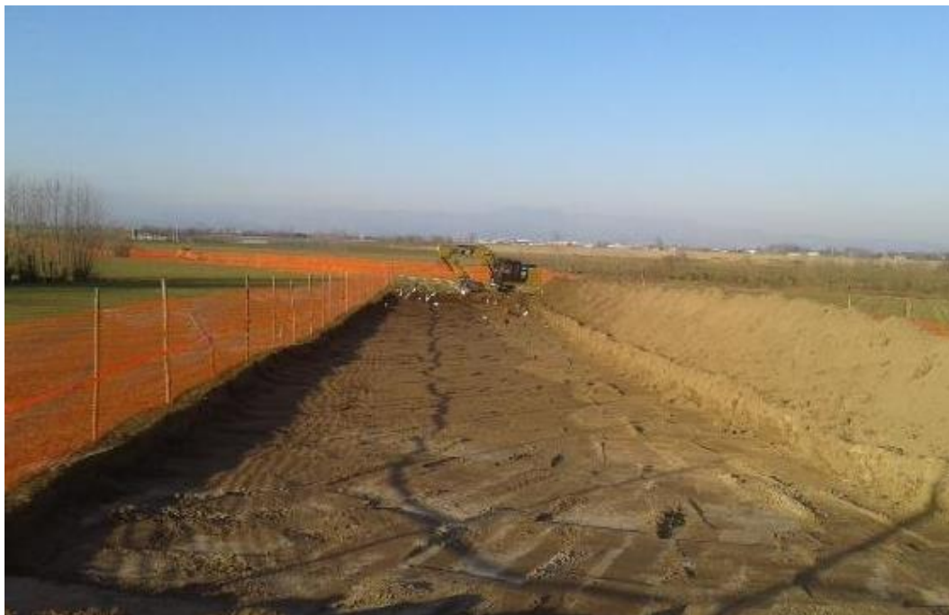
Figura 2-2 - Foto di apertura della pista di lavoro
