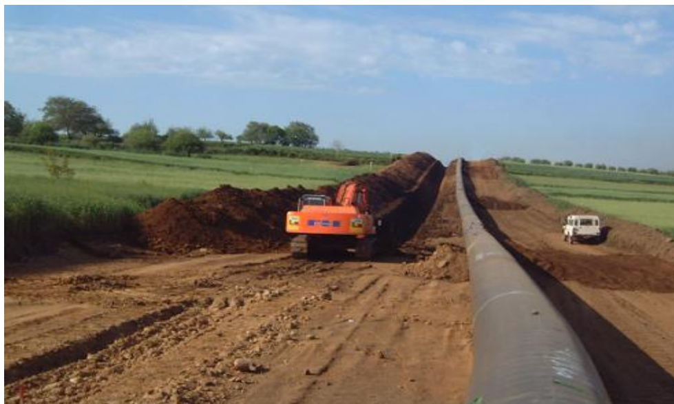
Figura 2-4 - Foto tipica di scavo della trincea
