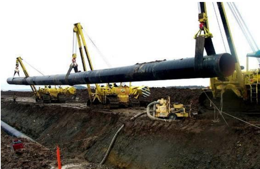
Figura 2-5 – Posa della condotta
