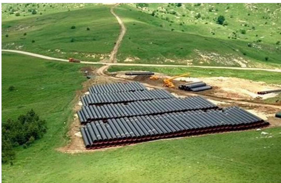
Figura 2-1 - Piazzola di accatastamento tubazioni
