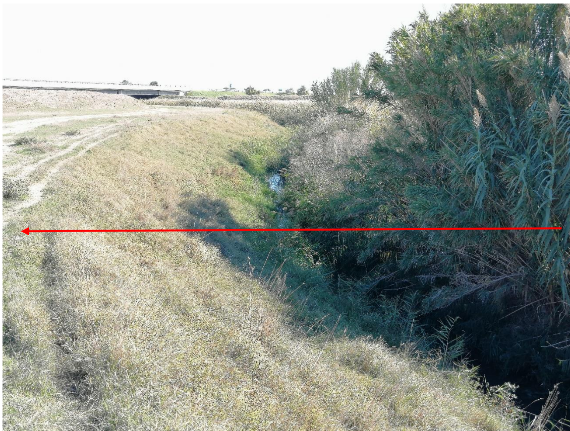
Fig. 5-3 – Torrente Salsola nei pressi dell'interferenza con il metanodotto in progetto Tratto 2 (in rosso il tracciato del metanodotto).
