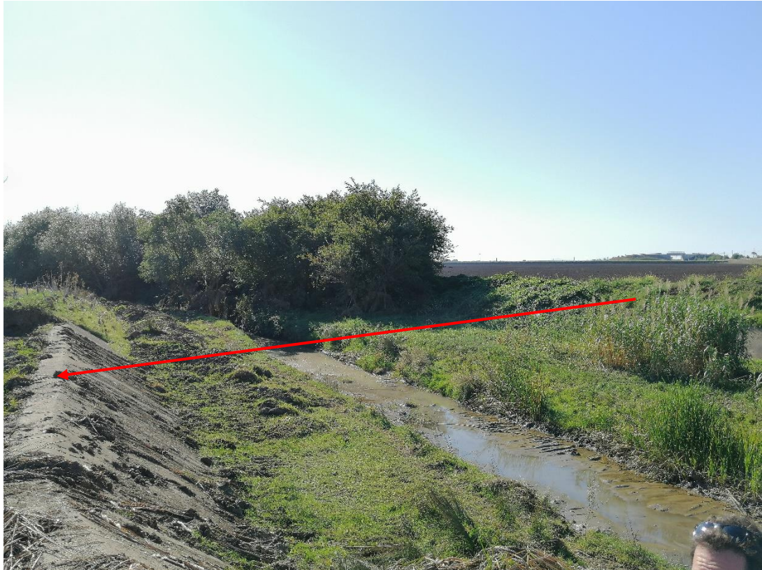
Fig. 5-5 – Torrente Candelaro nei pressi dell’interferenza con il metanodotto in Progetto Tratto 3 (in rosso il tracciato del metanodotto).
