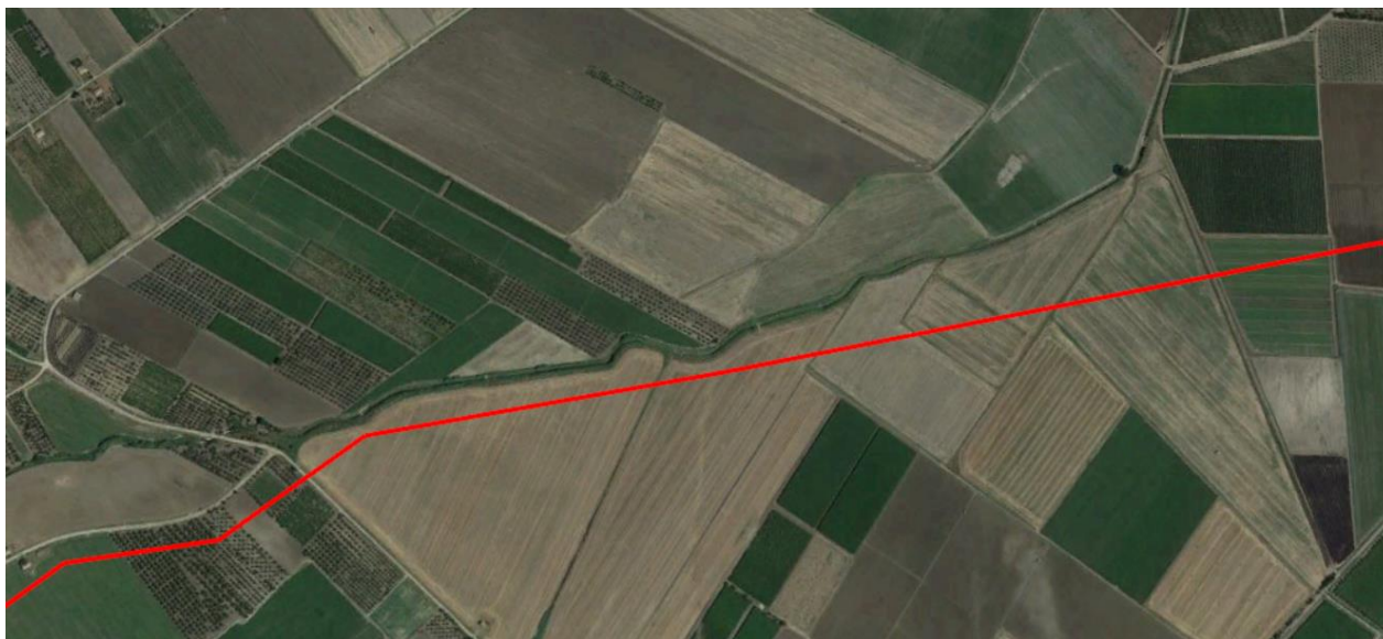
Fig. 5-5 – Prima percorrenza del Vallone del Rovello da parte del metanodotto in progetto Tratto 4.
