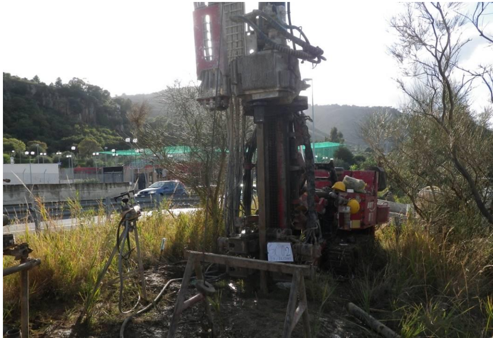
Posizionamento sondaggio SC02
