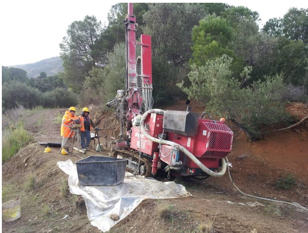
Posizionamento sondaggio SC01
