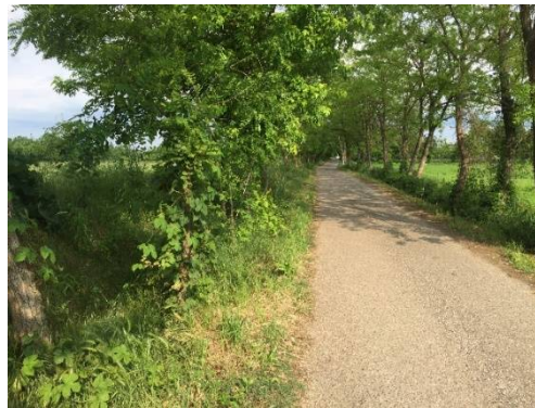
Strada collegamento Via Manzoni-Via Cavour
