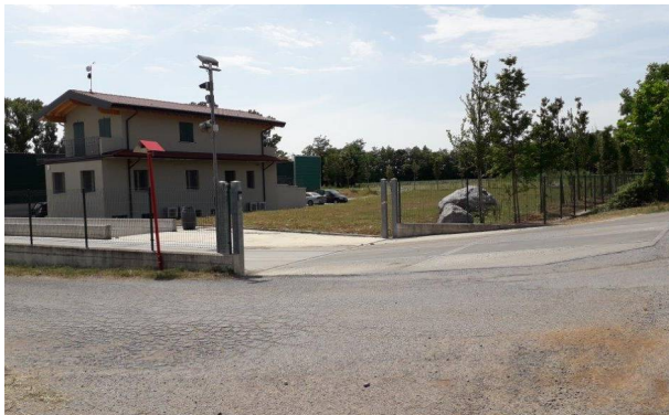
Accesso Stabilimento Ovest WTE srl
