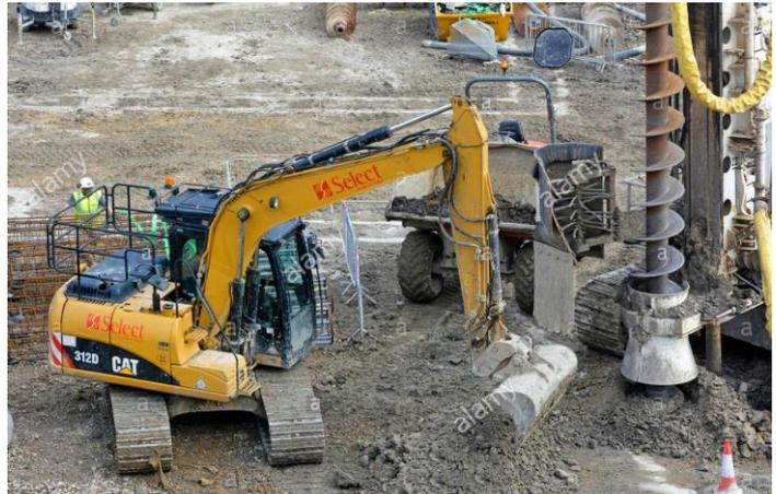
**Figura 5.1: tecniche di scavo tradizionali, a sinistra il cucchiaio a destra l'elica continua.**
