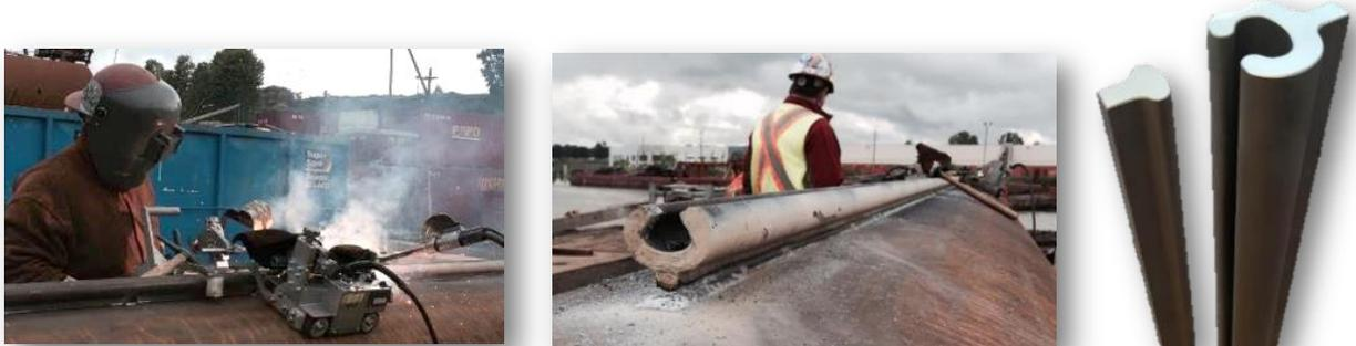
**Figura 5.5: Gargame ad omega durante la fase di saldatura lungo il fusto del lamierino.**
