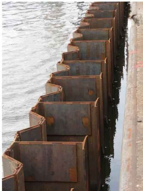
**Figura 5.2: Muro combinato di palancole e travi di irrigidimento**
