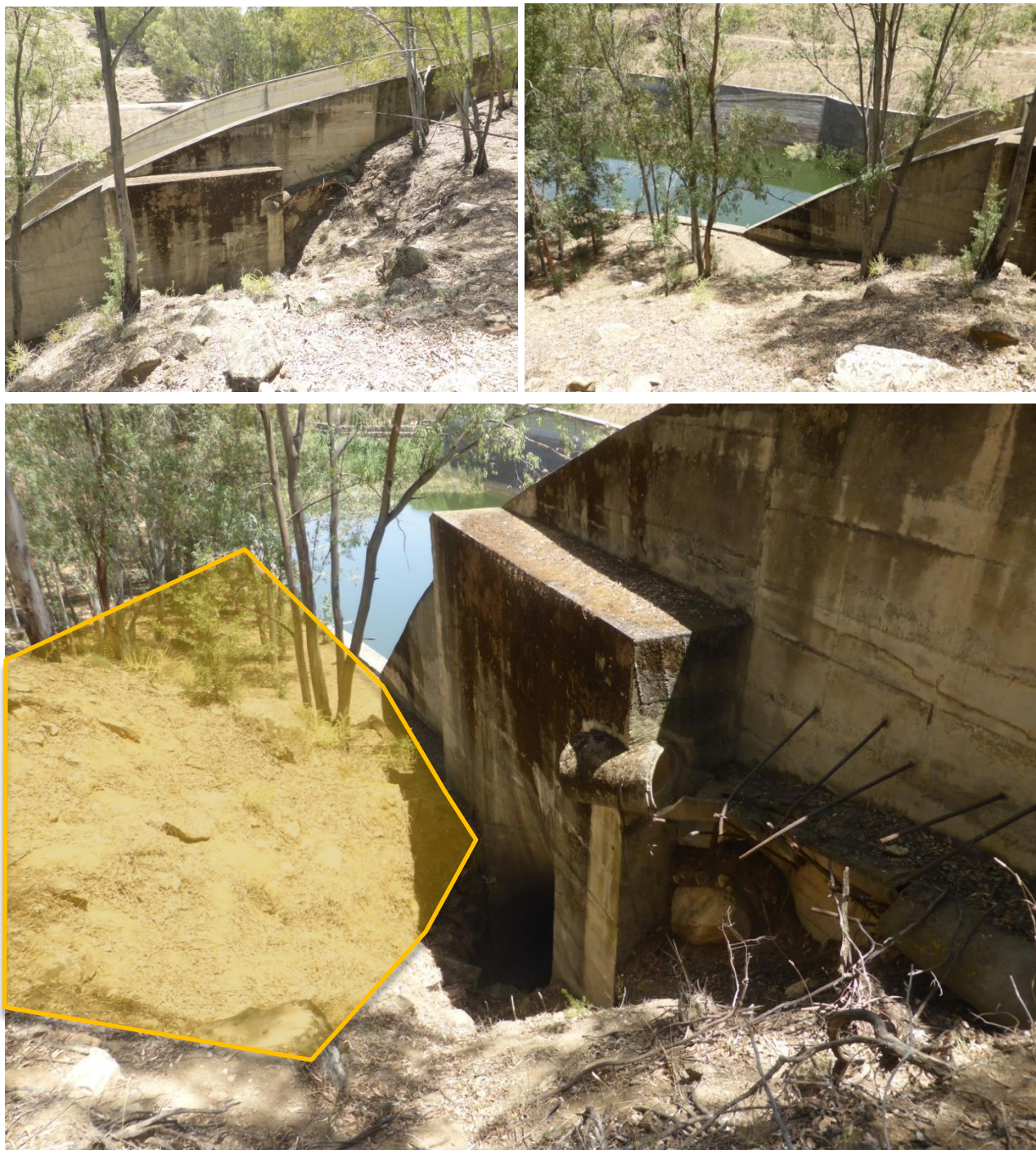
Figura 5-13: caditoia del canale intasato di sedimento, dove sarà realizzato un pozzetto con griglia di protezione e area di deviazione del canale, mediante creazione di un nuovo fosso
