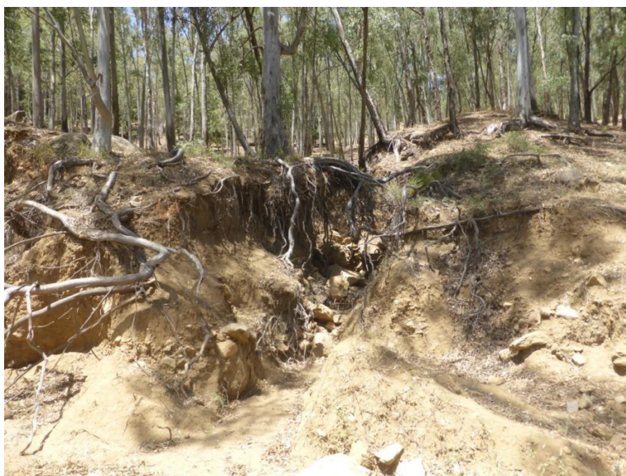
Figura 5-15: dissesto erosivo in atto sul versante
