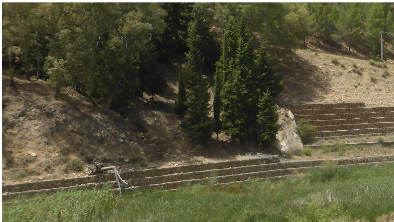
Figura 7-4: gabbionate esistenti in prossimità e a valle della vasca
