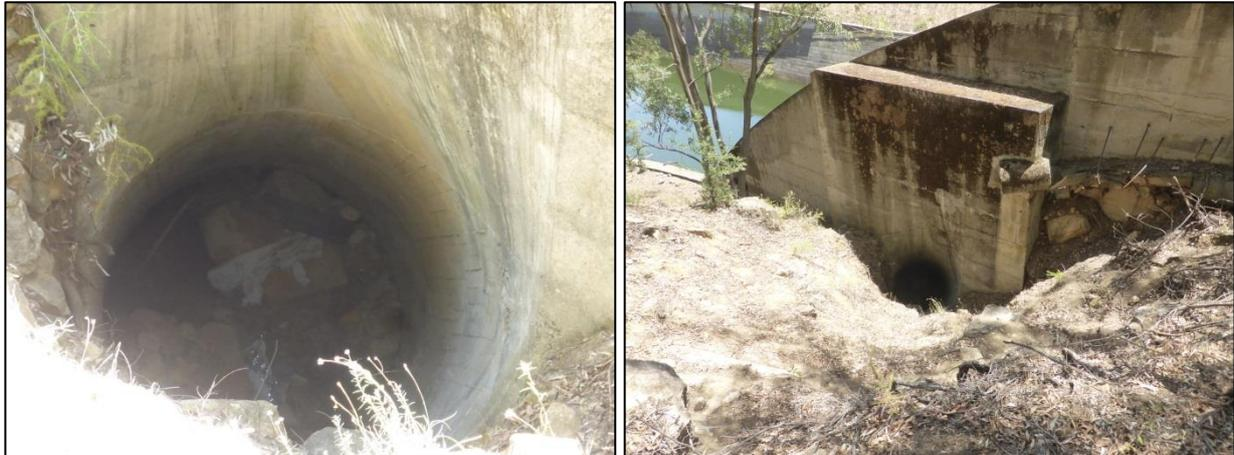
Figura 3-23: deposito di sedimento all'interno della caditoia intasato dai sedimenti dell'area in dissesto
