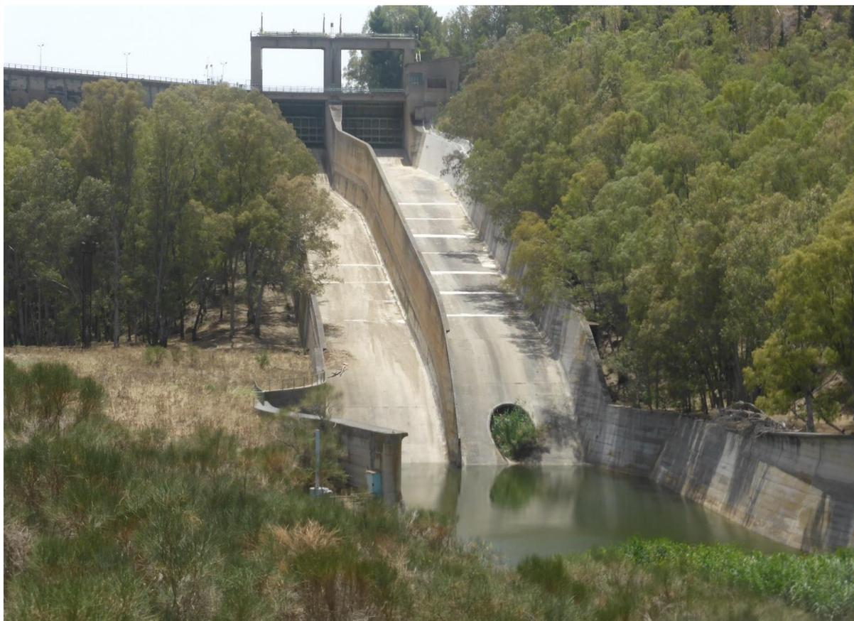
Figura 2-25. Diga del Pozzillo, scarico di superficie e sbocco della galleria dello scarico di fondo
