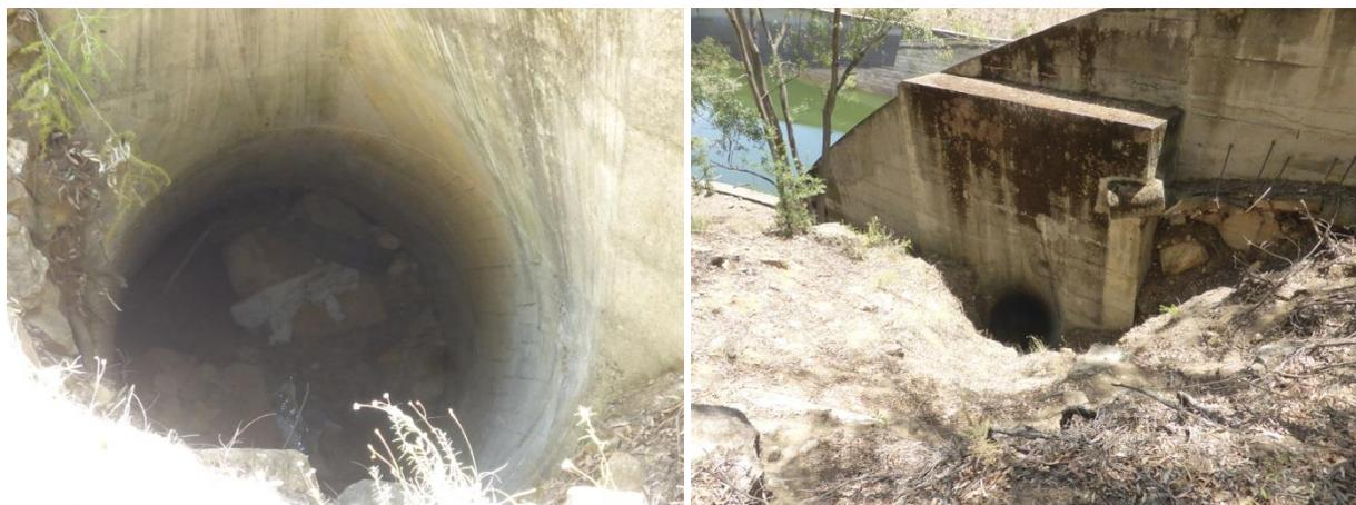
Figura 2-48. Deposito di sedimento all'interno della caditoia intasato dai sedimenti dell'area in dissesto
