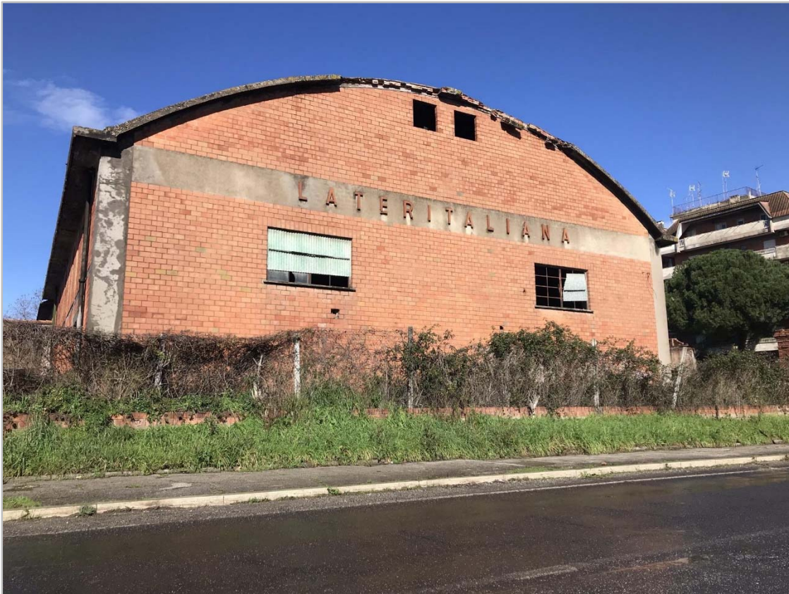
Figura 25 La fabbrica di mattoni "Lateritaliana" sulla Via Salaria (km 22.800) ad oggi in abbandono come gran parte delle strutture databili tra '800 e inizio '900.
