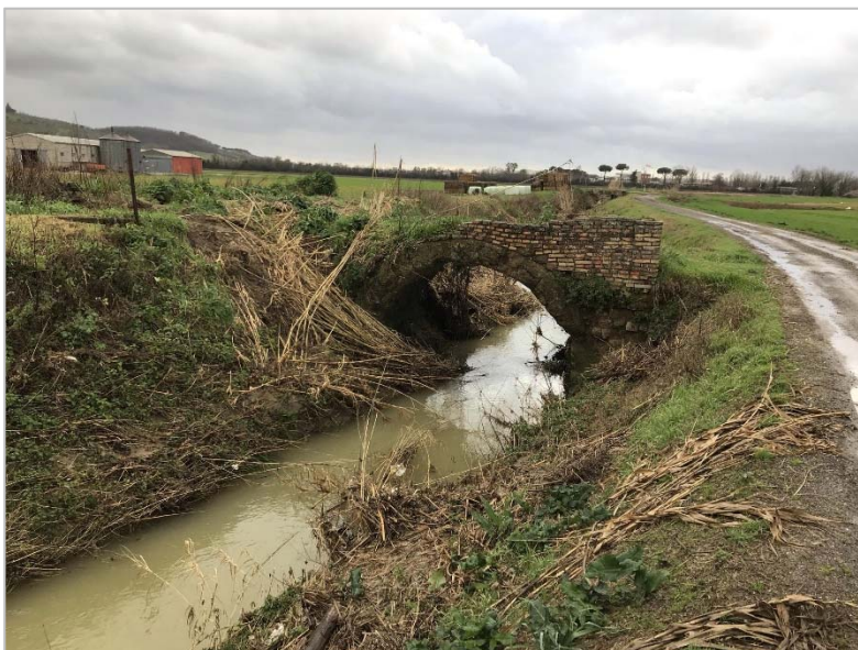
Figura 37 Il ponte (Presenza n. 16) nell'UR 8 al di sopra del F.sso Pantanelle (foto da PF.XXIV). La struttura non è incidente nell'area di progetto e non verrà intaccata nelle fasi di lavorazione.
