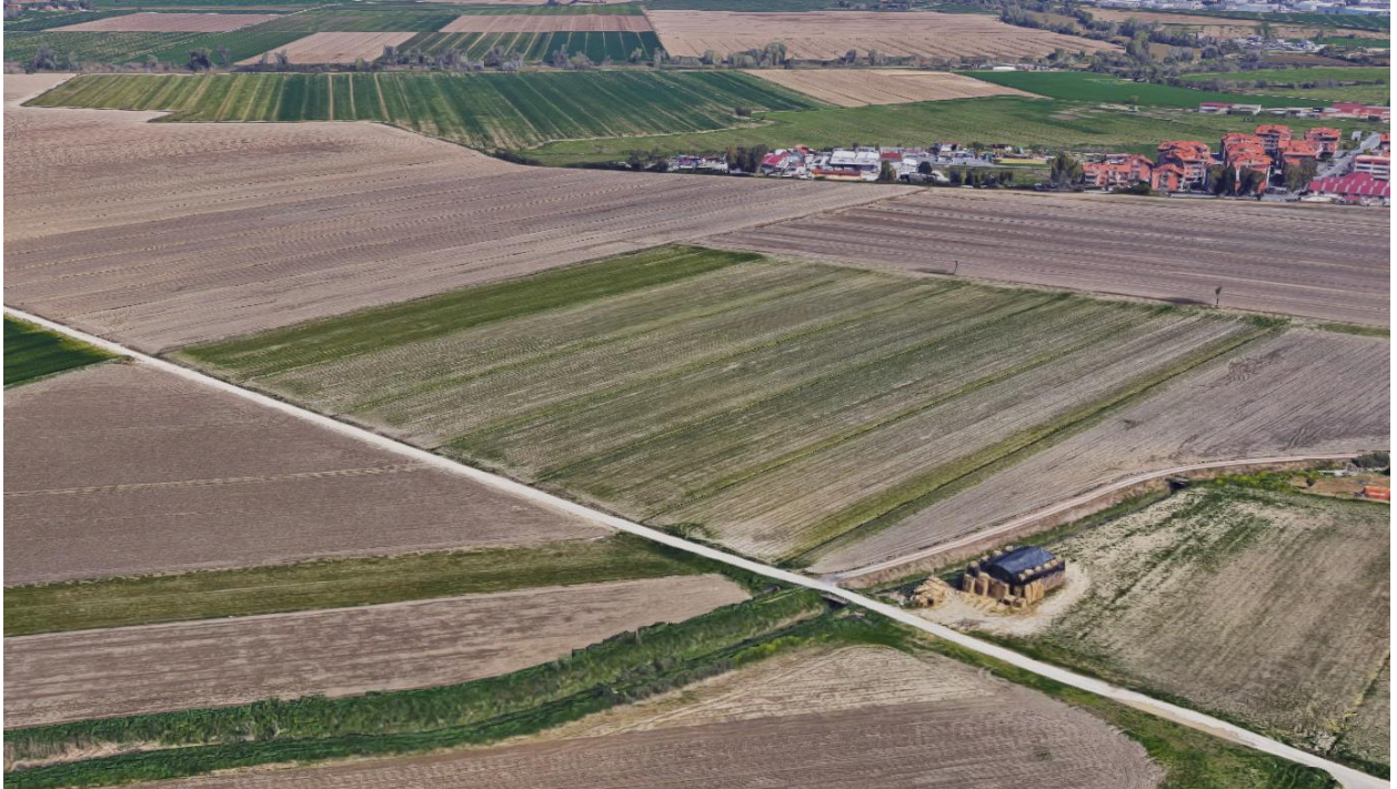
Figura 7-3 – Area di cantiere (stato attuale).
