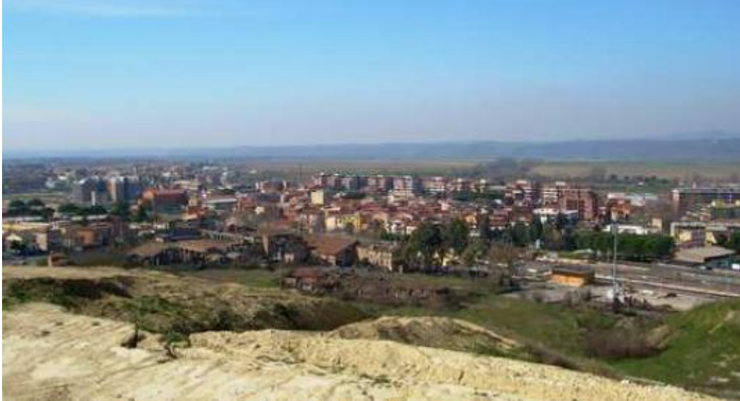
Figura 58 – Vista di Monterotondo Scalo verso il Tevere
