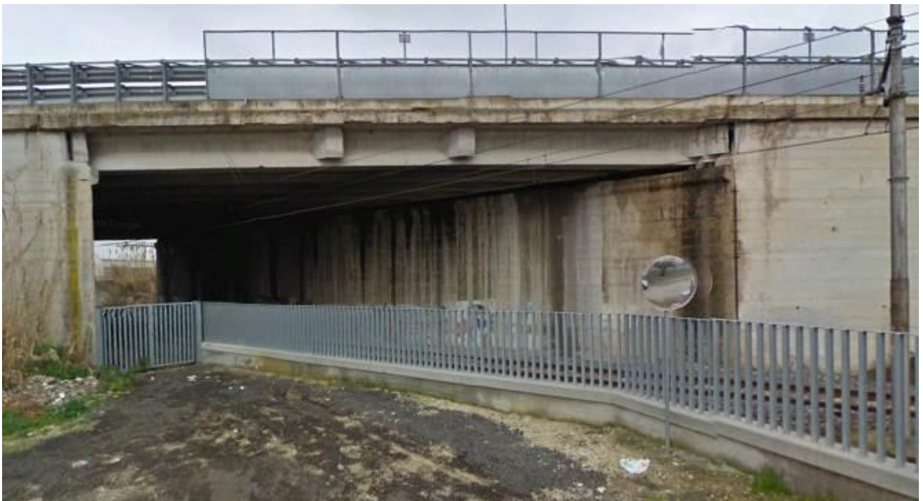
Fig. 7 – Sotto-atteversamento esistente Asse Attezzato PE-CH
