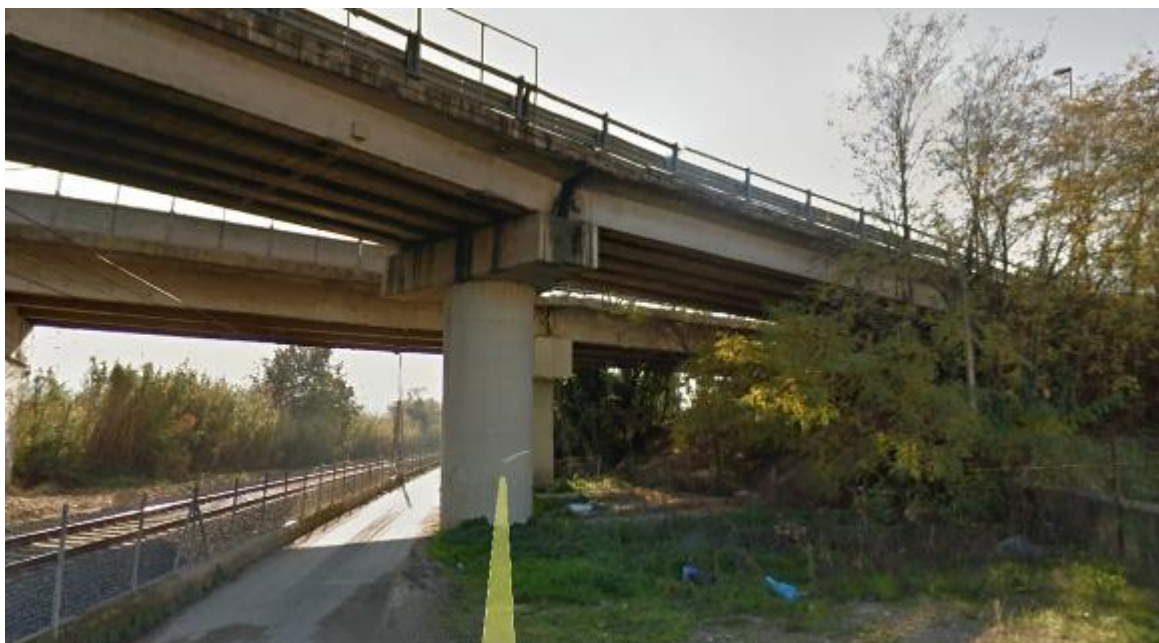
Figura 1 - Viabilità stradale alternativa a Via Vella - vista del ponte esistente in corrispondenza del quale vi sarà l'attraversamento del tracciato della nuova viabilità
