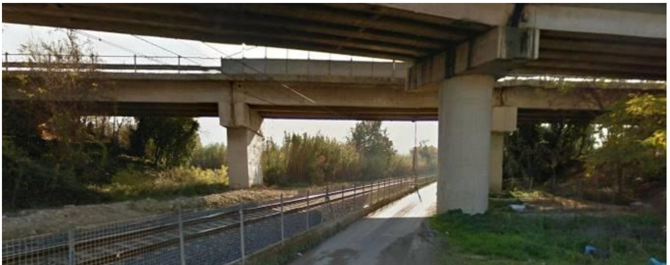
Fig. 11 – Sotto-atteveramento CVF rampa di raccordo dell'Autostrada A25
