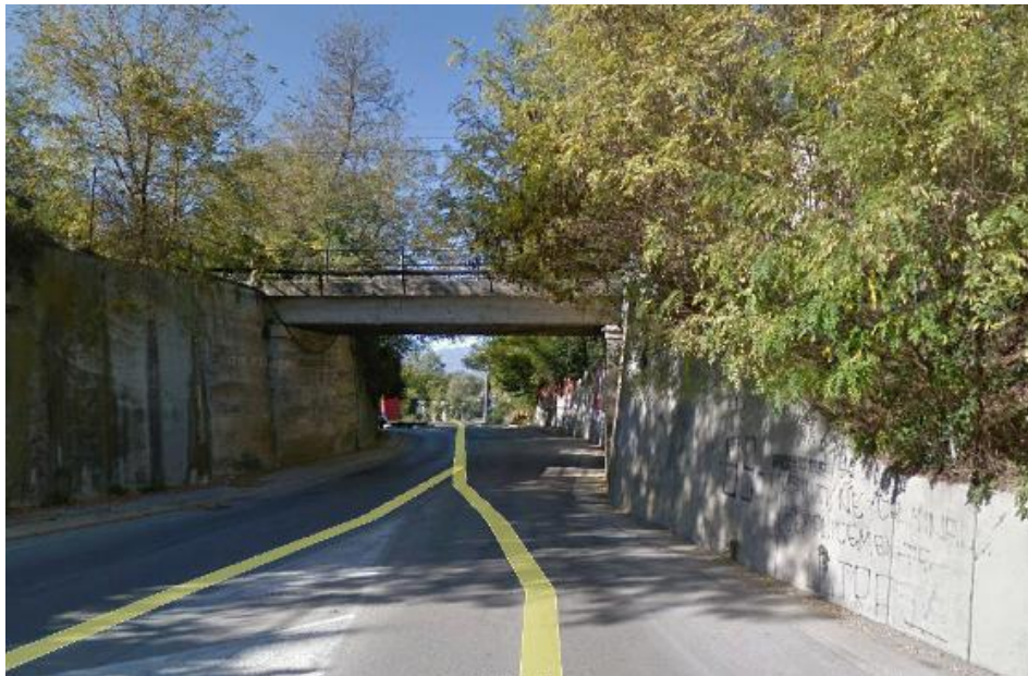
Fig. 54 – Viabilità stradale Via Tirino, sottovia al km 14+250.00 (NV34) Vista sottovia esistente lato est
