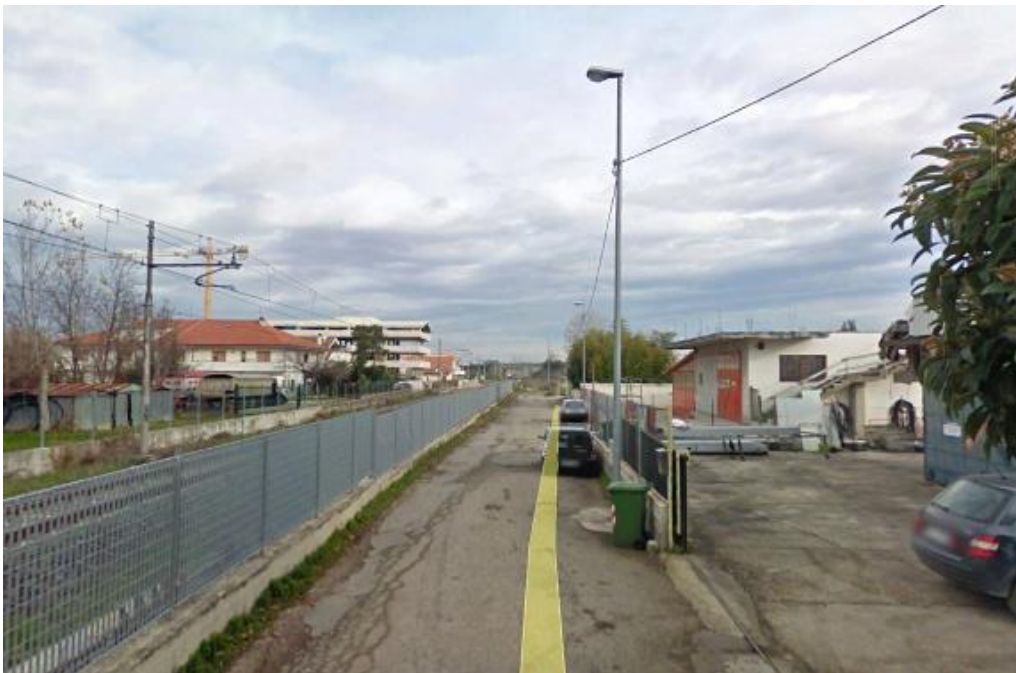
Fig. 52 – Viabilità stradale Via Vibrata, tratto interrotto dalla nuova sede ferroviaria
