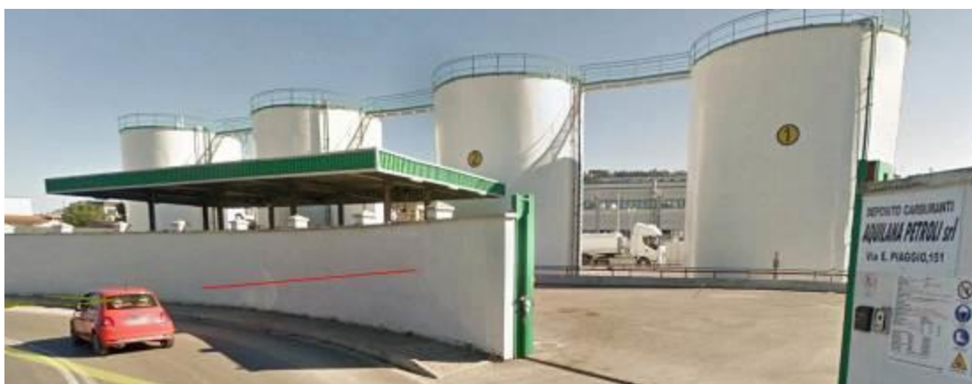
Fig. 5 – Deposito carburante esistente al km 13+400 circa
