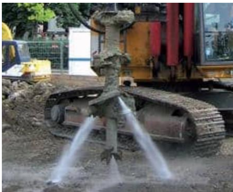
Figura 2: Particolare pulizia ugelli in wet deep mixing
