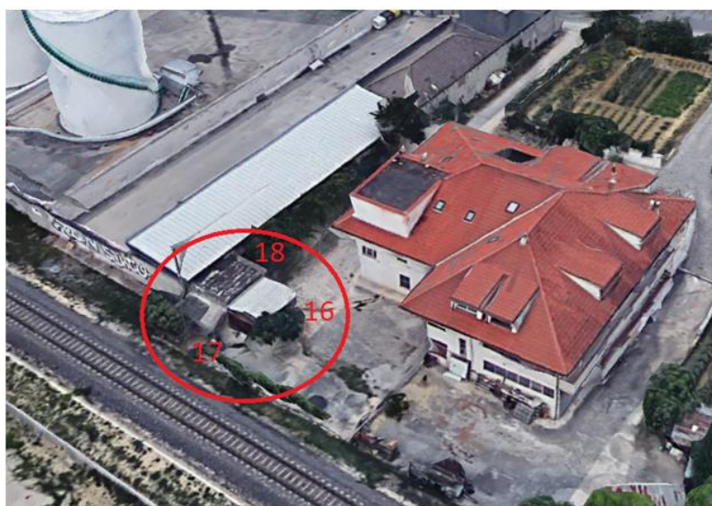
Fig. 31 - Vista Fabbricati 16, 17 e 18
