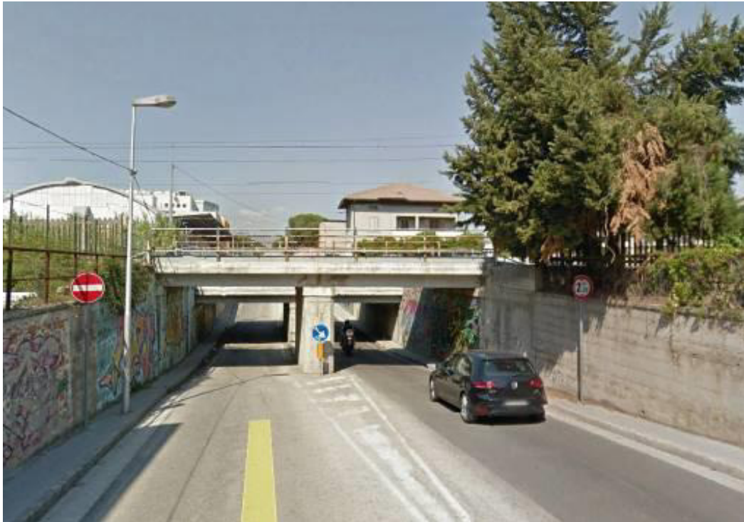
Fig. 47 – Viabilità stradale di Via Enrico Mattei al km 12+950,000 (NV31) - vista sottovia esistente (dir. E. Piaggio)
