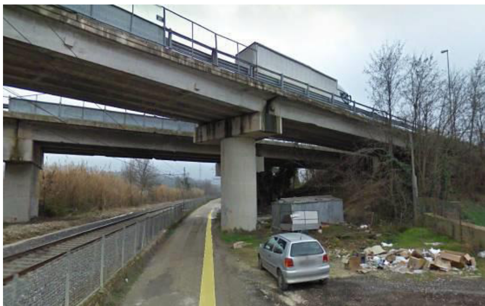
Fig. 56 – Viabilità stradale alternativa a Via Vella - vista del cavalcaferrovia autostradale esistente
