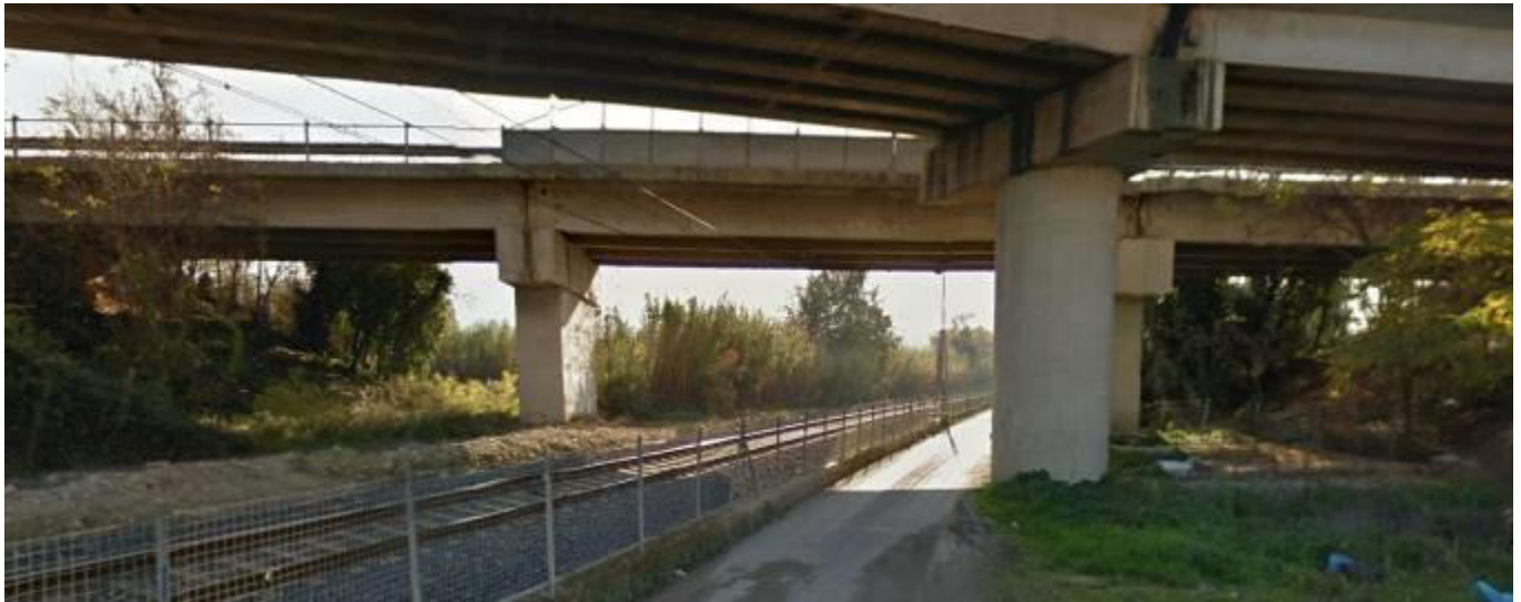
Fig. 11 – Sotto-attraversamento CVF rampa di raccordo dell'Autostrada A25
