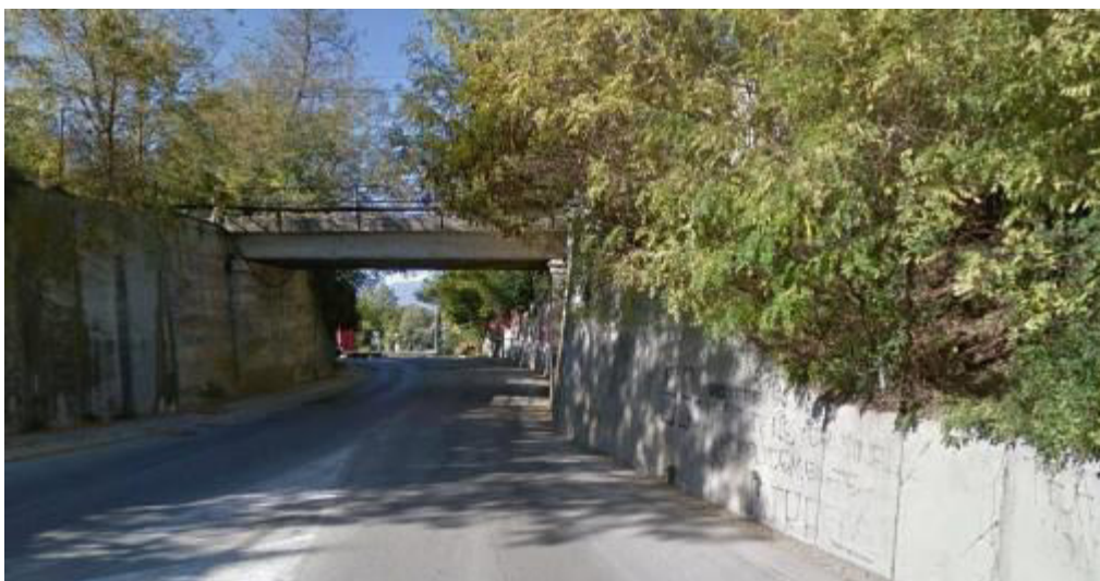
Fig. 9 – Ponte attuale su Via Tirino
