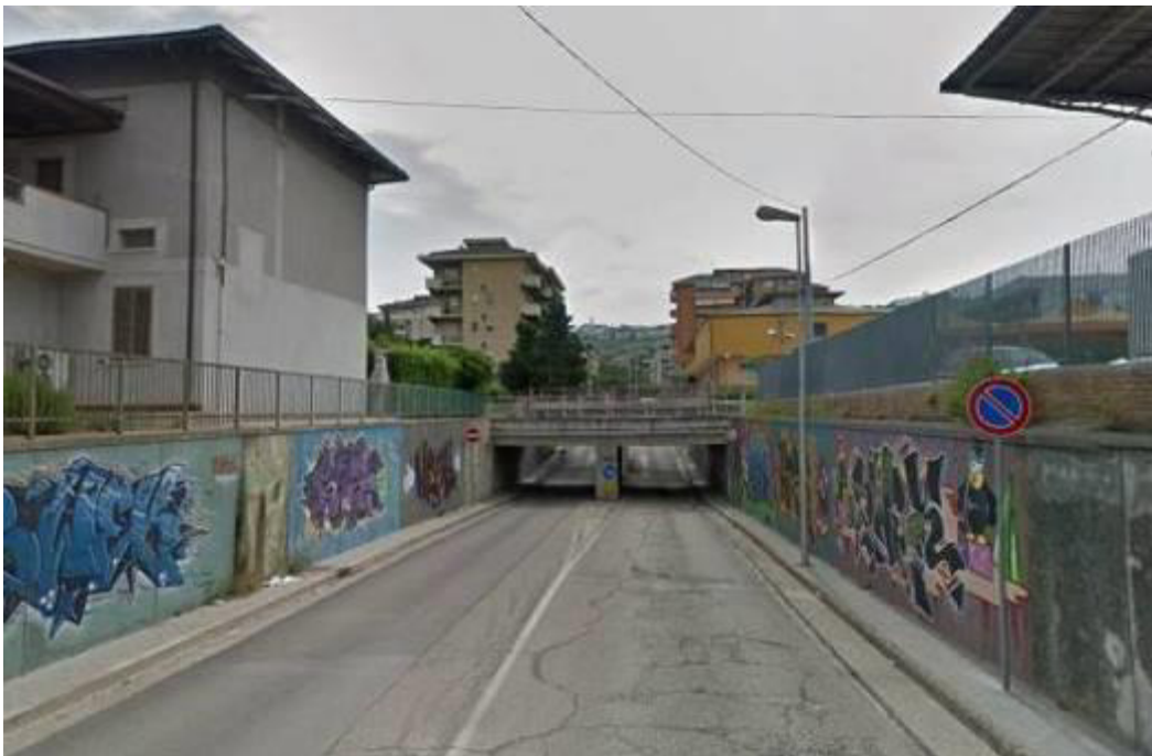
Fig. 48 – Viabilità stradale di Via Enrico Mattei al km 12+950,000 (NV31) - vista sottovia esistente (dir. SS5)
