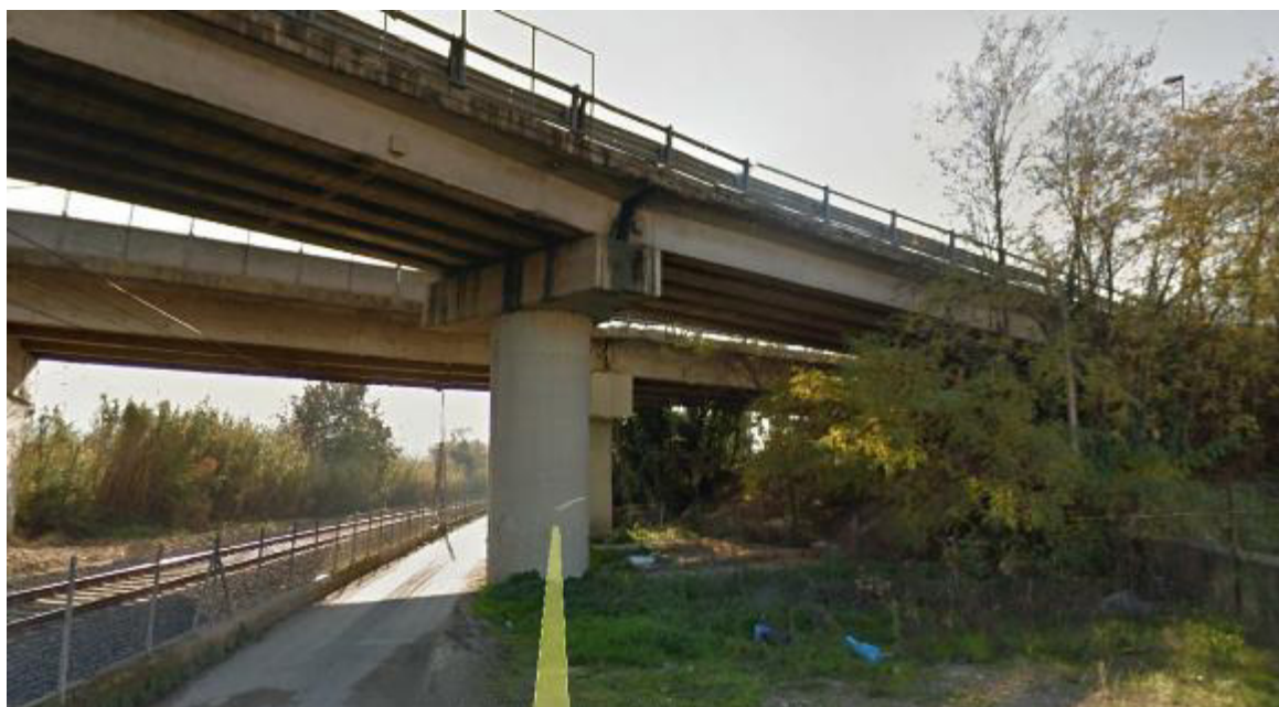
Fig. 57 – Viabilità stradale alternativa a Via Vella - vista del ponte esistente in corrispondenza del quale vi sarà l'attraversamento del tracciato della nuova viabilità
