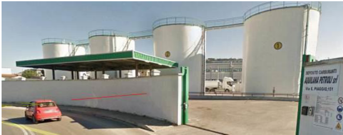
Fig. 5 – Deposito carburante esistente al km 13+400 circa
