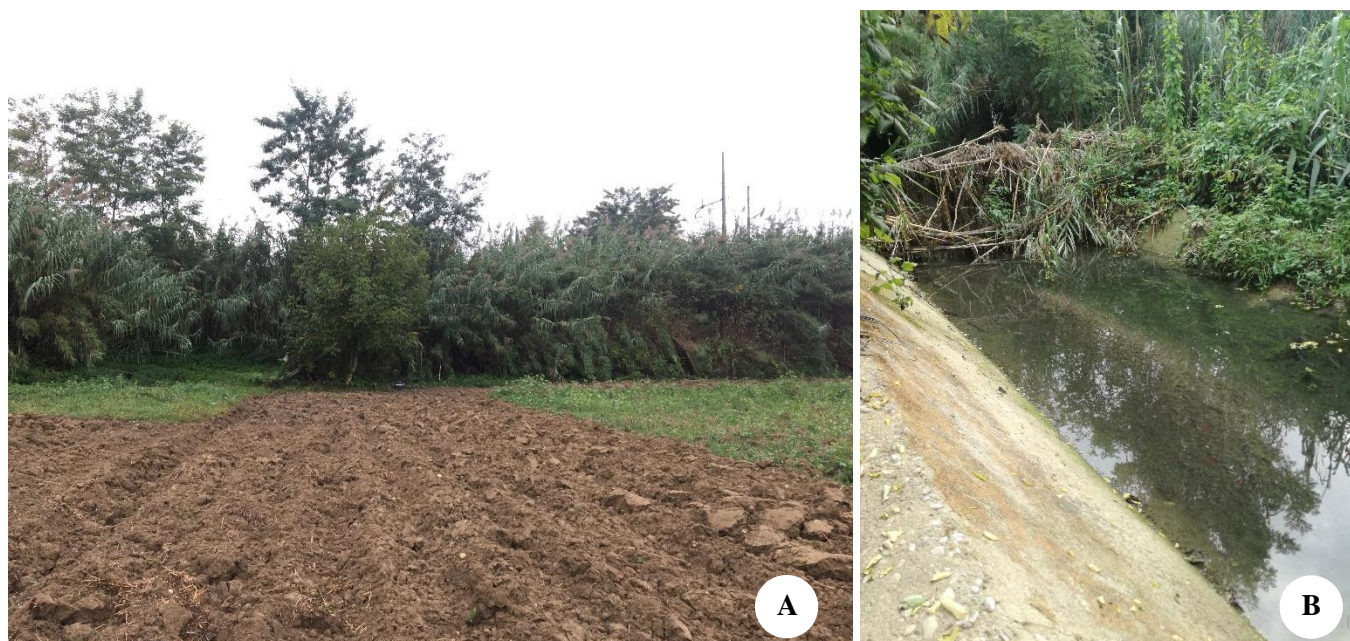
Figura 6-5 Principali elementi geomorfologici legati all'azione antropica: scarpata antropica legata al rilevato ferroviario (a), canalizzazione del F.so Pretaro in prossimità della linea ferroviaria (b).
