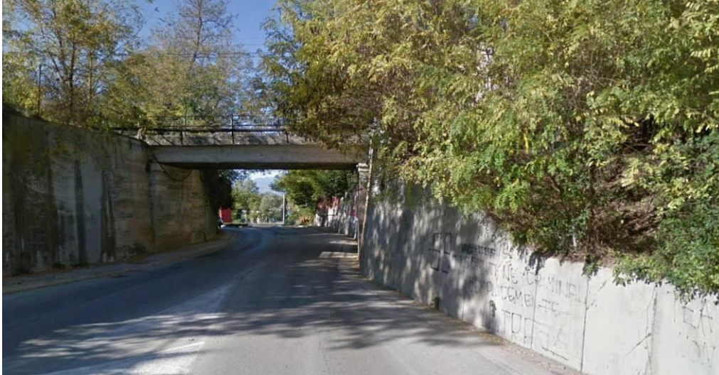
Figura 2-6: Ponte attuale su Via Tirino
