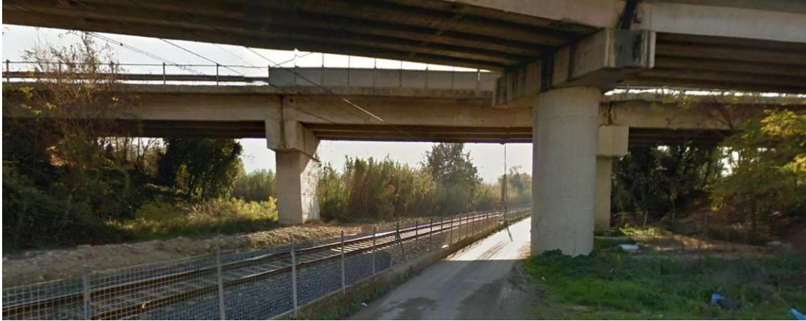
Figura 2-8: Sotto-atteveramento CVF rampa di raccordo dell'Autostrada A25
