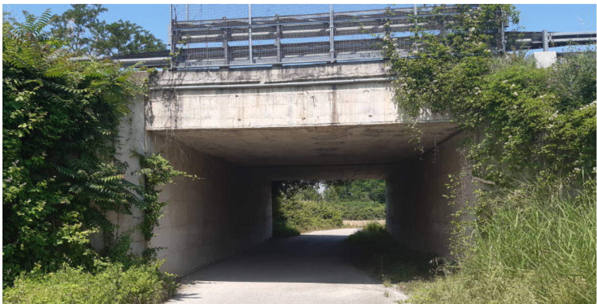
Vista del sottopasso di via Tirino., strada vicinale
