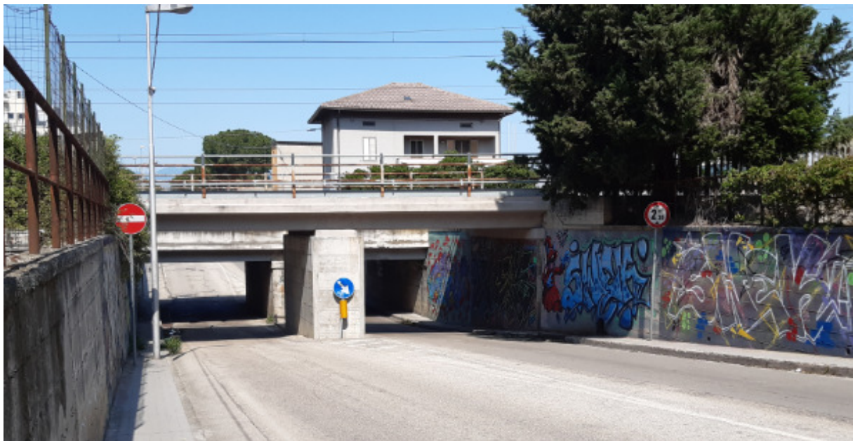
Vista dei sottopassi da via ss5
