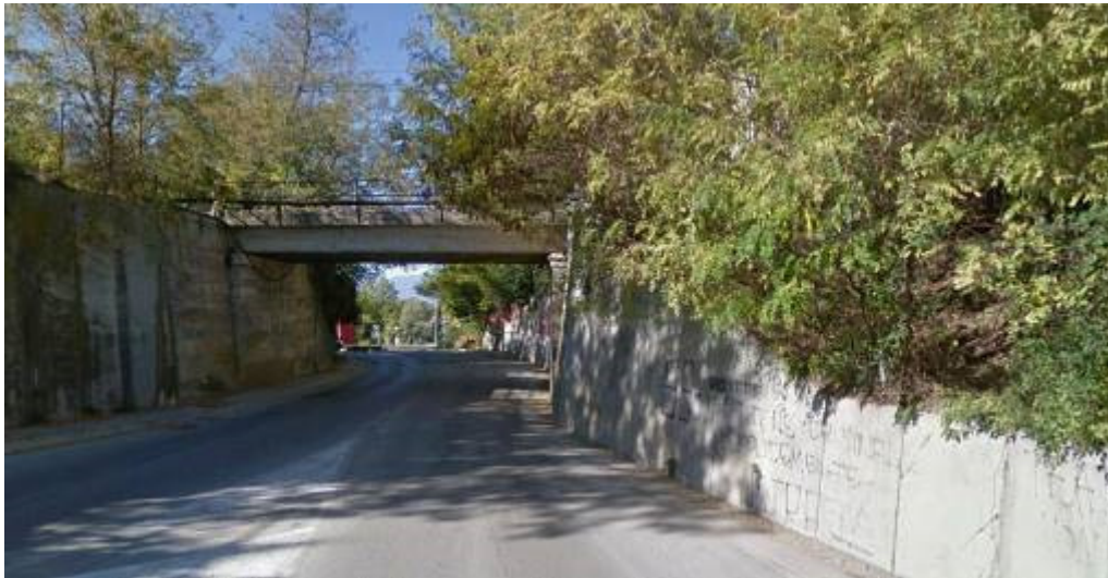
Fig. 7 – Ponte attuale su Via Tirino
