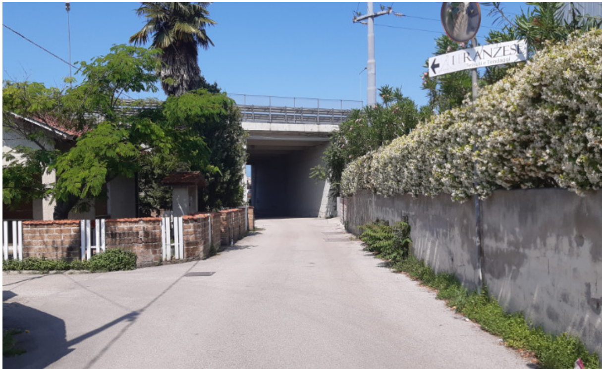
Vista del sottopasso di via Vibrata.
