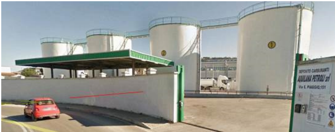
Fig. 3 – Deposito carburante esistente al km 13+400 circa
