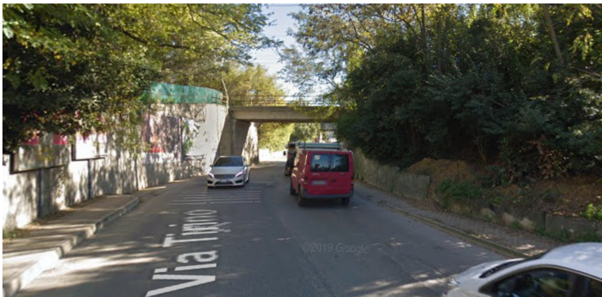
Vista dell'attuale viadotto ferroviario da via Tirino
