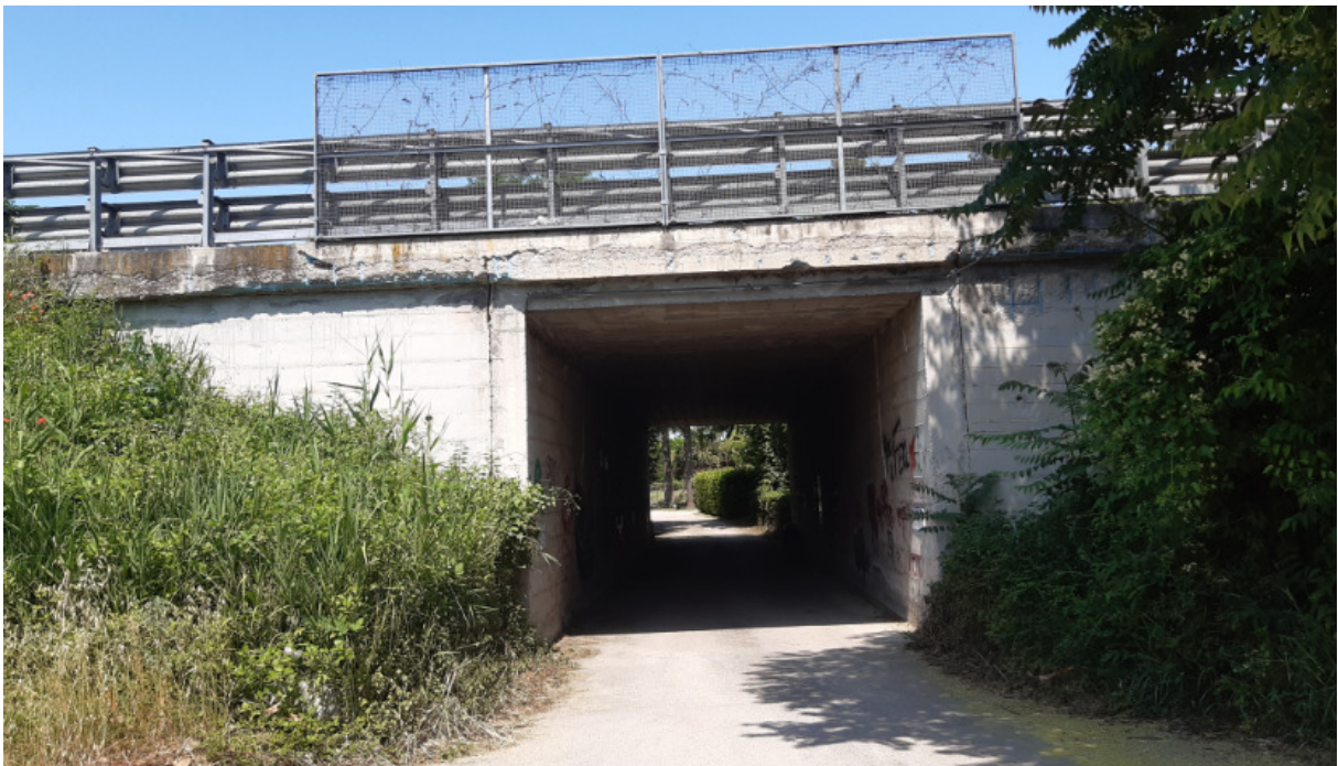
Sottopasso di via Salinello
