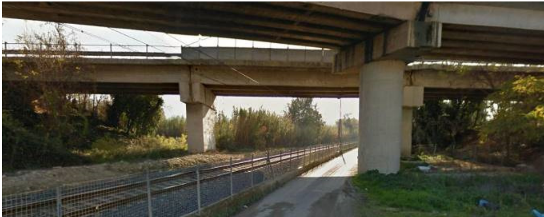
Fig. 9 – Sotto-attraversamento CVF rampa di raccordo dell'Autostrada A25
