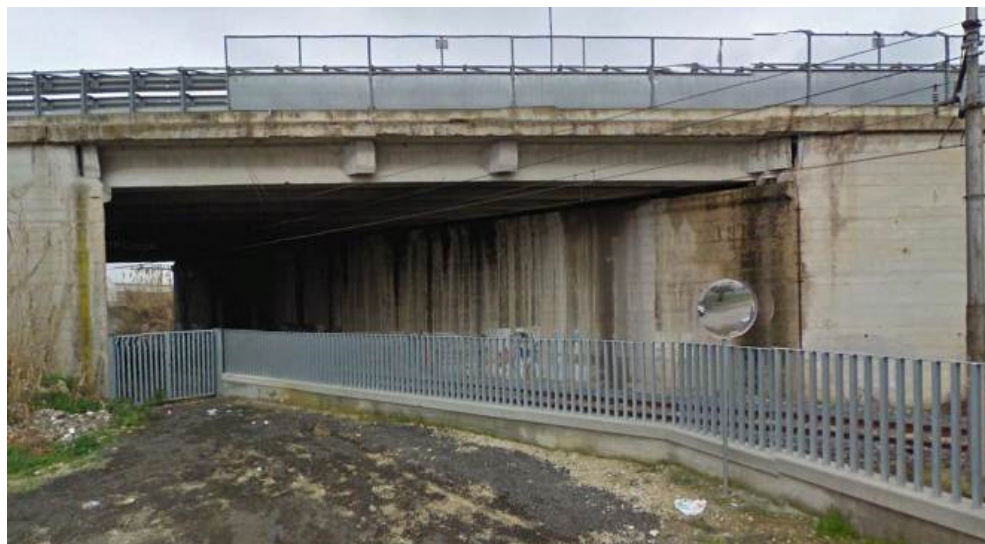
Fig. 5 – Sotto-attraversamento esistente Asse Attrezzato PE-CH
