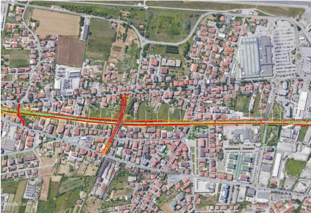
Fig. 10 – Raddoppio ferroviario dal km 3+200 al km 4+550
