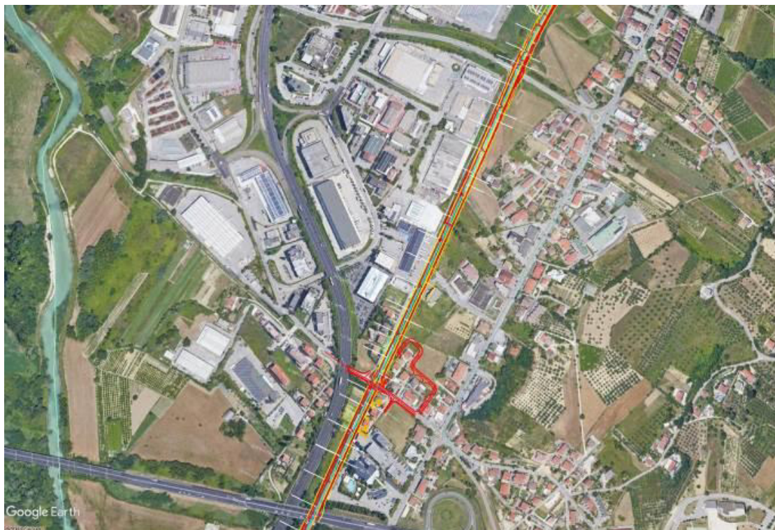
Fig. 15 – Sede ferroviaria in prossimità del km 7+000 circa
