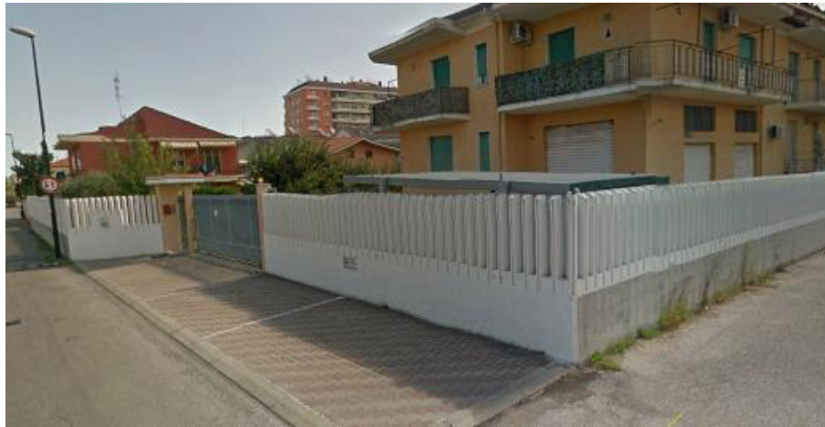
Fig. 4 – Muro di recinzione fabbricato
