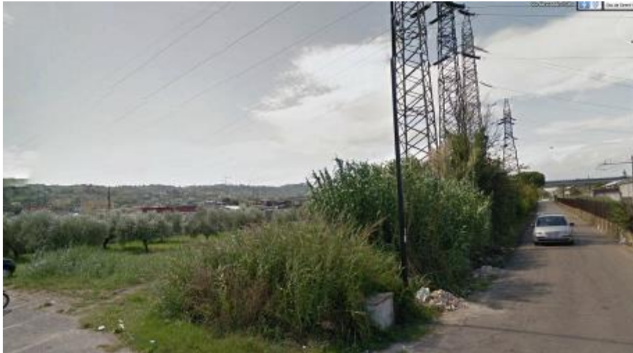
Fig. 6 – Tralicci alta tensione tra il km 1+600 ed il km 1+750
