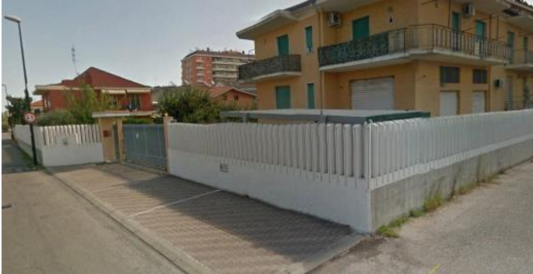
Fig. 4 – Muro di recinzione fabbricato
