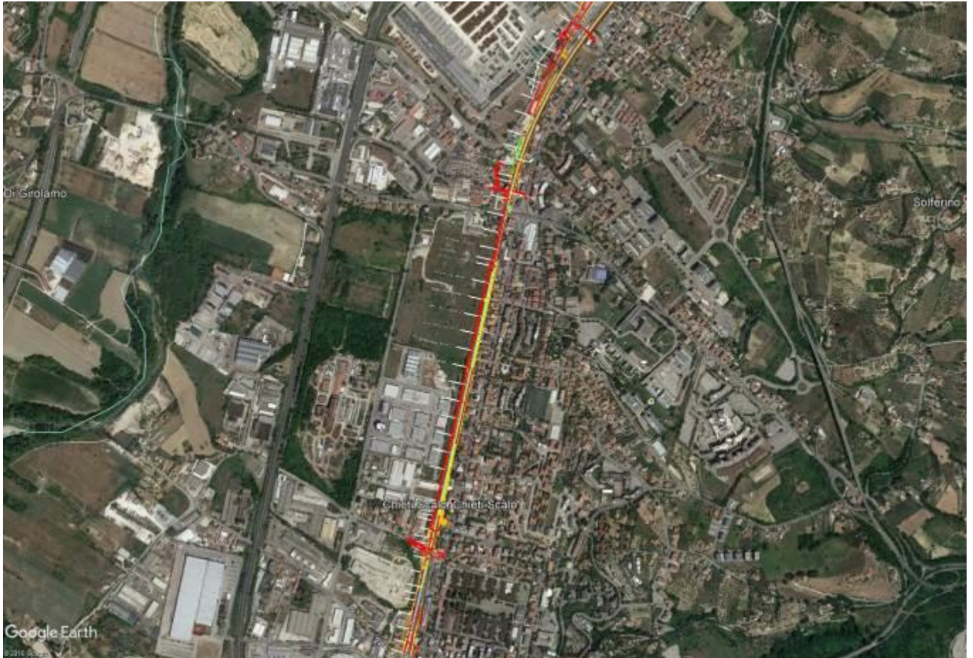
Fig. 20 – Raddoppio ferroviario dal km 10+883,350 a fine lotto 2
