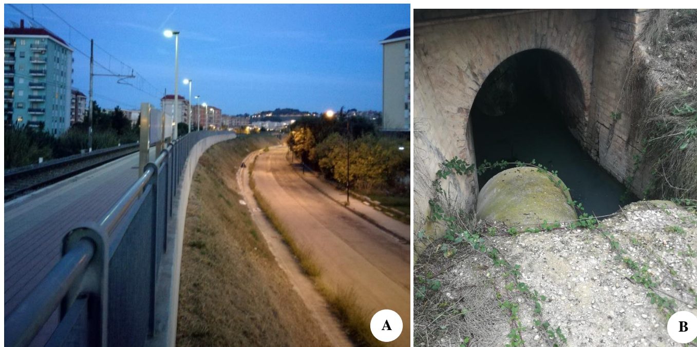
Figura 7-6. Principali elementi geomorfologici legati all'azione antropica: scarpata antropica legata al rilevato ferroviario in prossimità della Fermata San Marco (a), tombino idraulico in prossimità della linea ferroviaria nella futura fermata Aeroporto (b)
