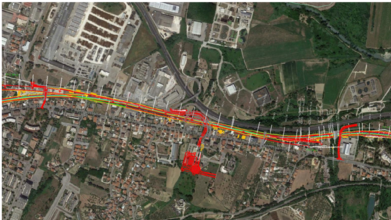
Figura 2-7 – Raddoppio ferroviario dal km 8+900 al km 10+150
