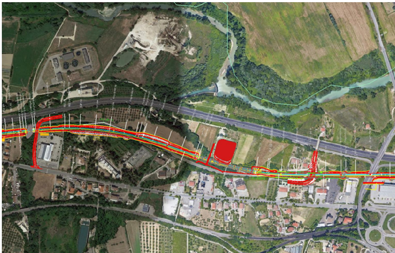
Figura 2-5 – Raddoppio ferroviario dal km 7+700 al km 8+900
