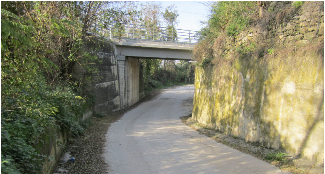
Vista di via Bassino e viadotto sulla LS.
