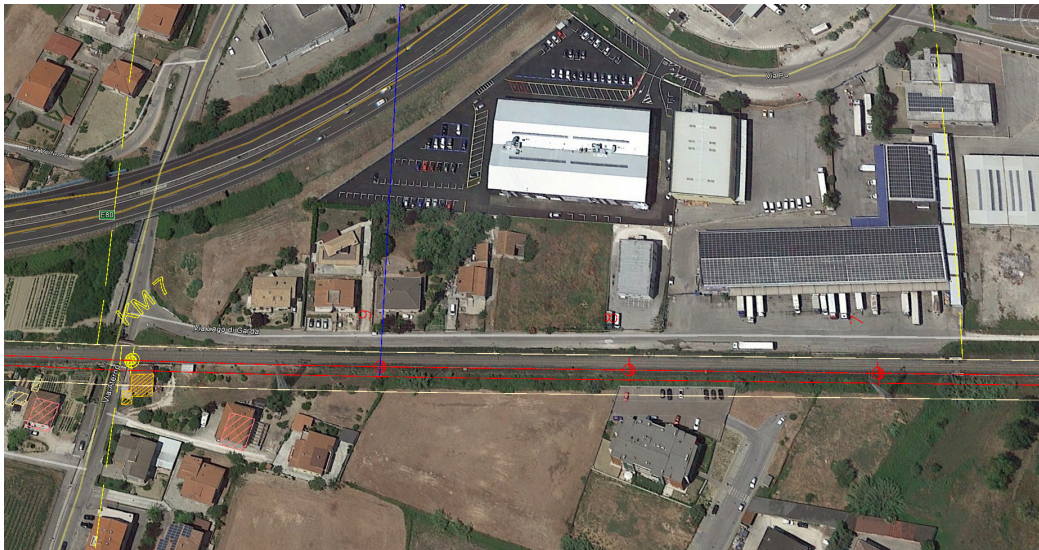
Sede ferroviaria in prossimità del km 7+000 circa
