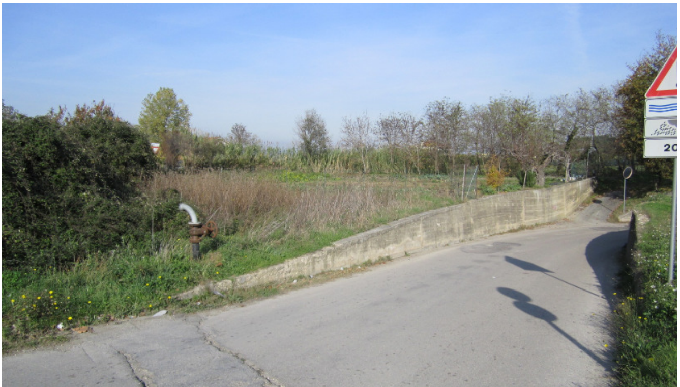
Vista dell'area AT.19 da via Carboni
