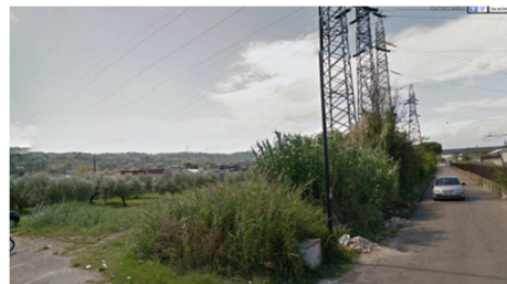
Figura 9 - Tralicci alta tensione tra il km 1+600 ed il km 1+750
