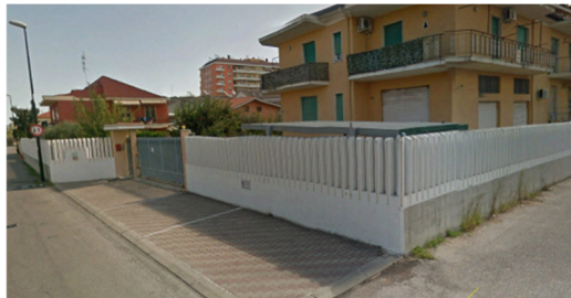
Figura 7 - Muro di recinzione fabbricato
