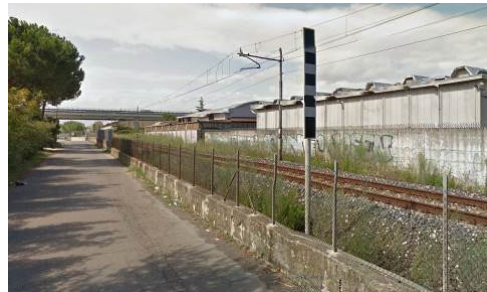
Figura 8 - Capannoni industriali al km 1+780 circa
