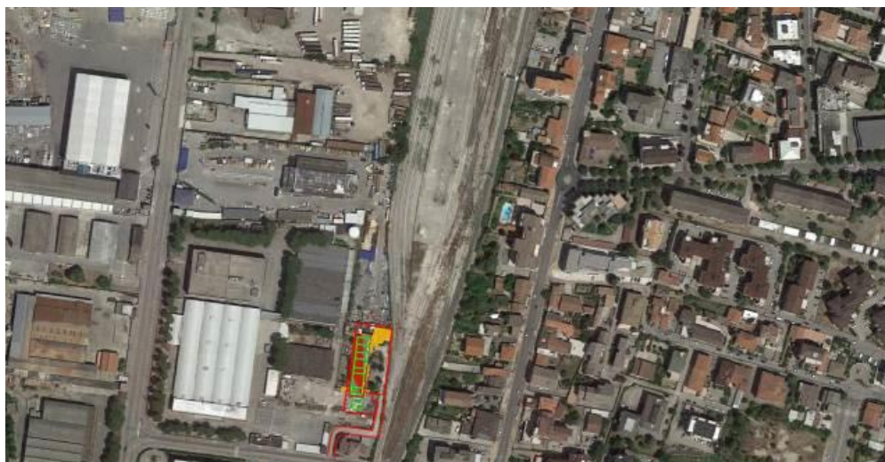
Fig. 32 - Viabilità stradale di accesso al piazzale tecnologico nella stazione di Chieti al km 12+883,370 (NV21)
