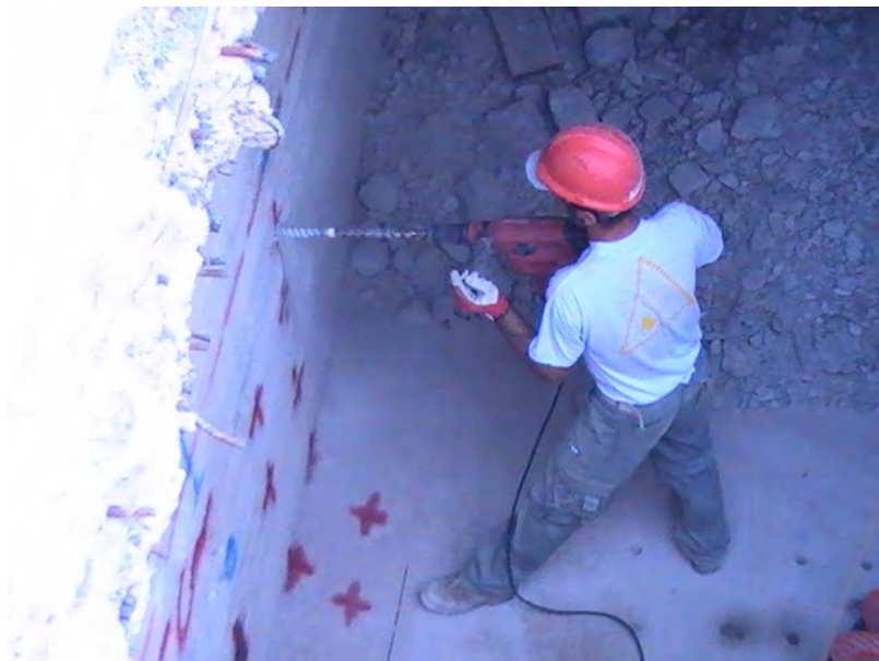
Perforazione con martello elettrico
