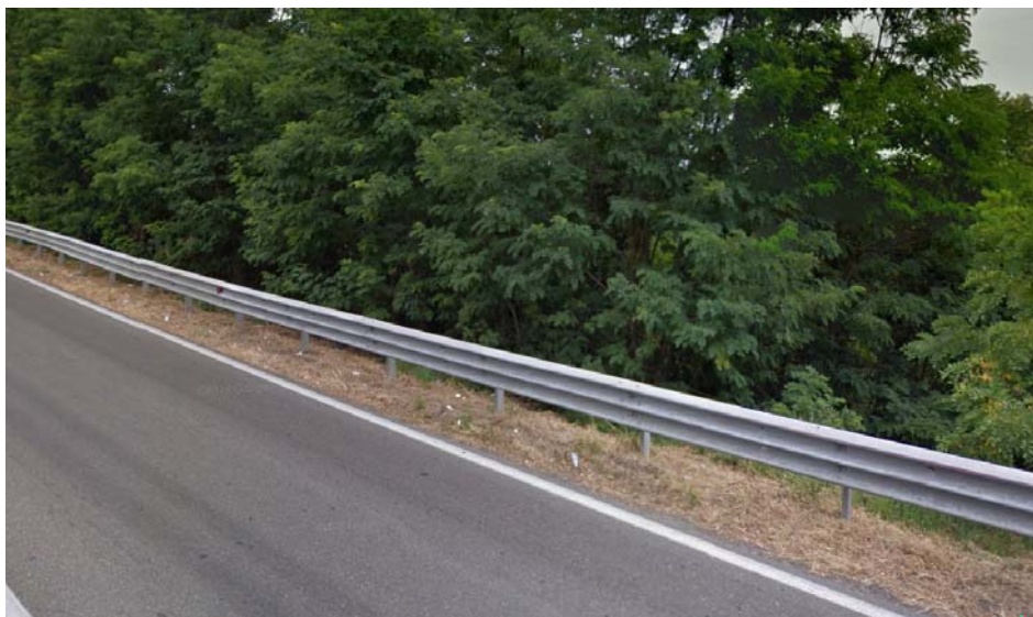
Barriera H2 BL esistente in corrispondenza dell'innesto della variante a nord di Zorlesco
