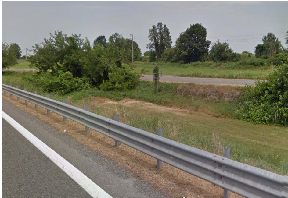
Barriera H2 BL esistente in corrispondenza dell'innesto della variante a sud di Casalpusterlengo
