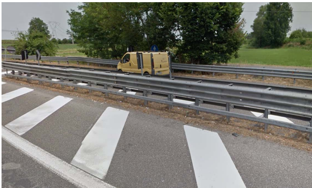
Barriera H3 spartitraffico esistente in corrispondenza dell'innesto della variante a sud di Casalpusterlengo
