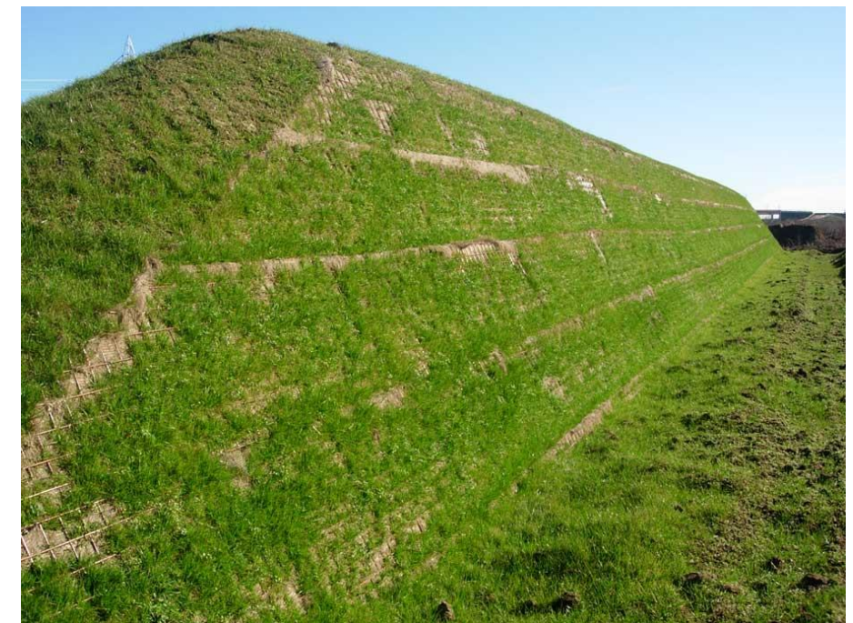
Duna in terra rinforzata
