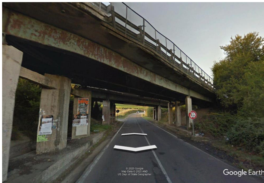
Figura 9 – Sottovia svincolo di Florinas
