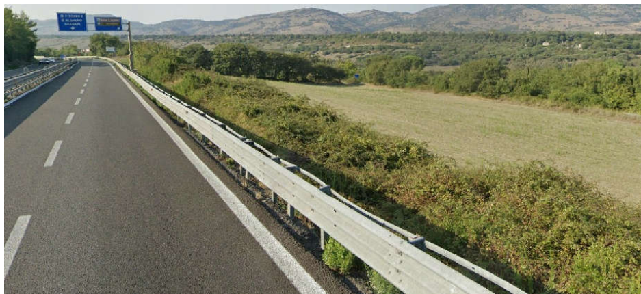
Vista dell'area dalla SS131 esistente
