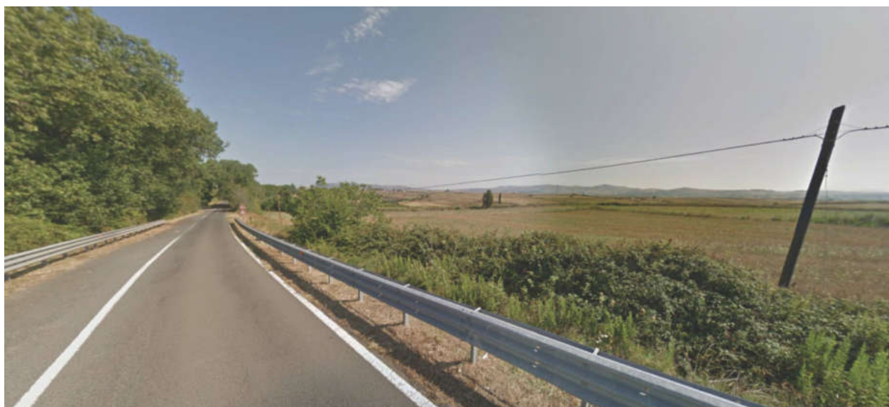
Vista dell'area dall'attuale rampa di svincolo
