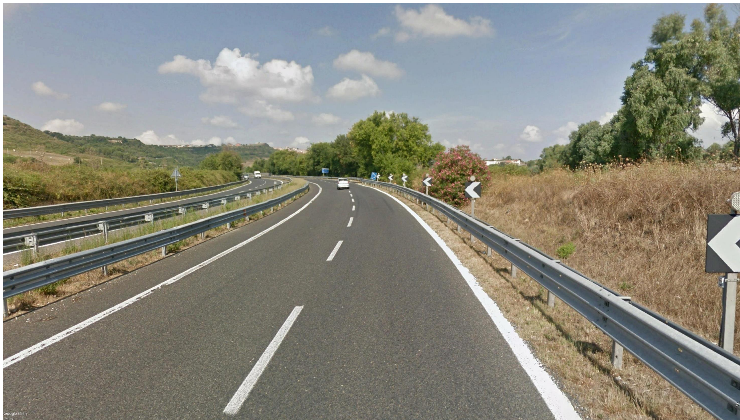
Punto 2: Progressiva 0+900.00. Vista da strada statale 131 "Carlo Felice" in direzione dello svicolo con la strada provinciale SP3. Nell'area inquadrata in foto, risulta visibile l'asse oggetto di intervento e sulla destra una vegetazione caratterizzata da "colture specializzate e arboree" come definite da PPR (fonte: Google Earth)
