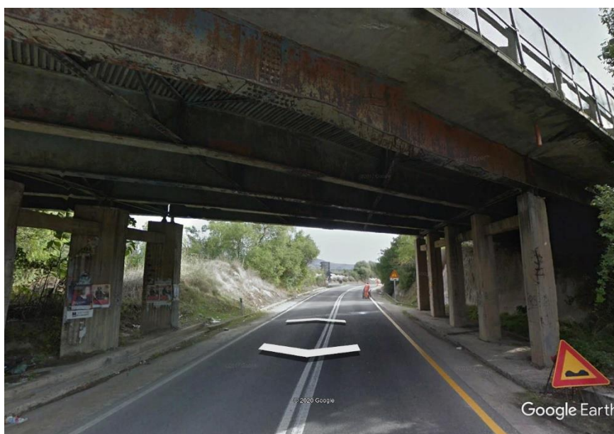
Figura 2-3 Sottovia svincolo di Codrongianos
