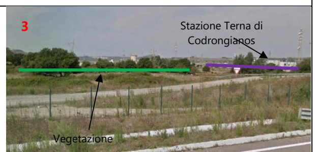
Vista da SS597, in direzione dell'asse stradale principale al km 0+500 circa. La visuale del tracciato è ostacolata dalla presenza di vegetazione ed elementi dell'edificato.
