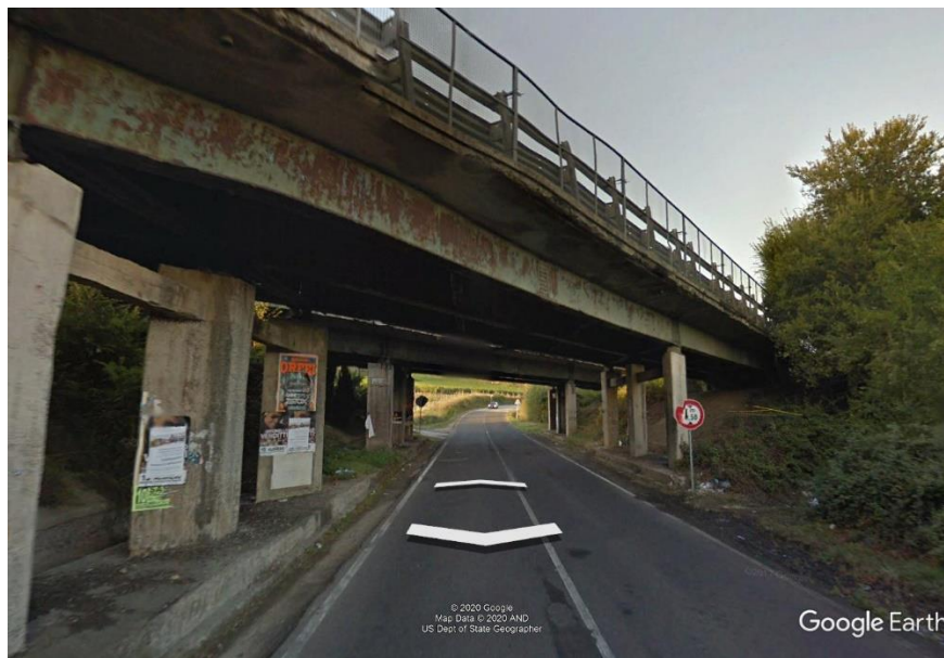
Figura 2-2 Sottovia svincolo di Florinas
