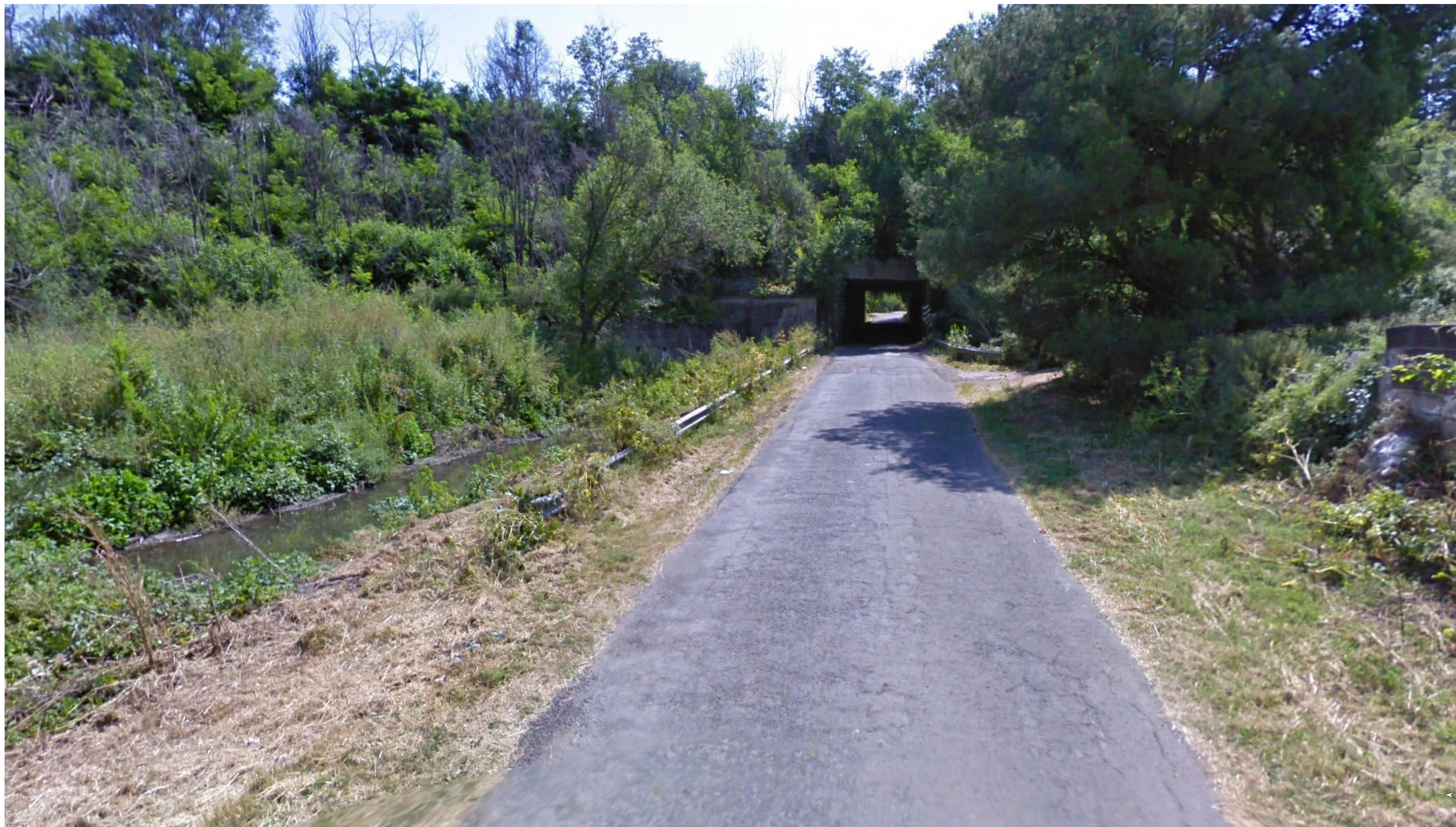
Punto 11: Progressiva 3+570.00: Vista dalla Strada Provinciale 152 in direzione est. Nell'area inquadrata in foto, risulta visibile l'asse stradale con in lontananza un sottopasso carrabile. Sulla sinistra si può notare il corso d'acqua Riu Pedra Nedda, vincolato dal PPR ai sensi dell'art.143 del D.Lgs.42/04. L'immagine mostra inoltre una fitta vegetazione costituita da "colture erbacee specializzate, aree agroforestali, aree incolte", come definita da PPR, proprio in corrispondenza del corso d'acqua che attraversa la strada perpendicolarmente.
