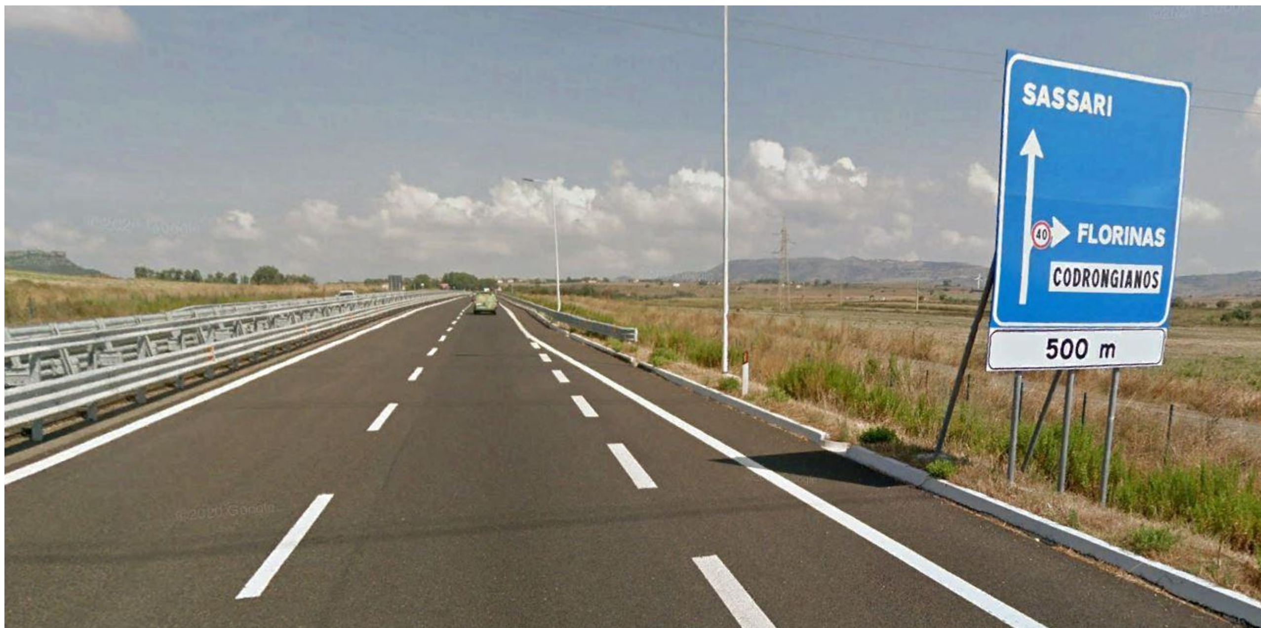
Punto 1: Progressiva 0+000.00: Vista dalla Strada Statale 131 "Carlo Felice" in direzione nord verso i comuni di Florinas e Codrongianos. (fonte: Google Earth). Consiste nel tratto iniziale dell'intervento oggetto di studio nella cui prossimità insiste un'area caratterizzata secondo PPR da "colture erbacee specializzate, aree agoforestali, aree incolte".
