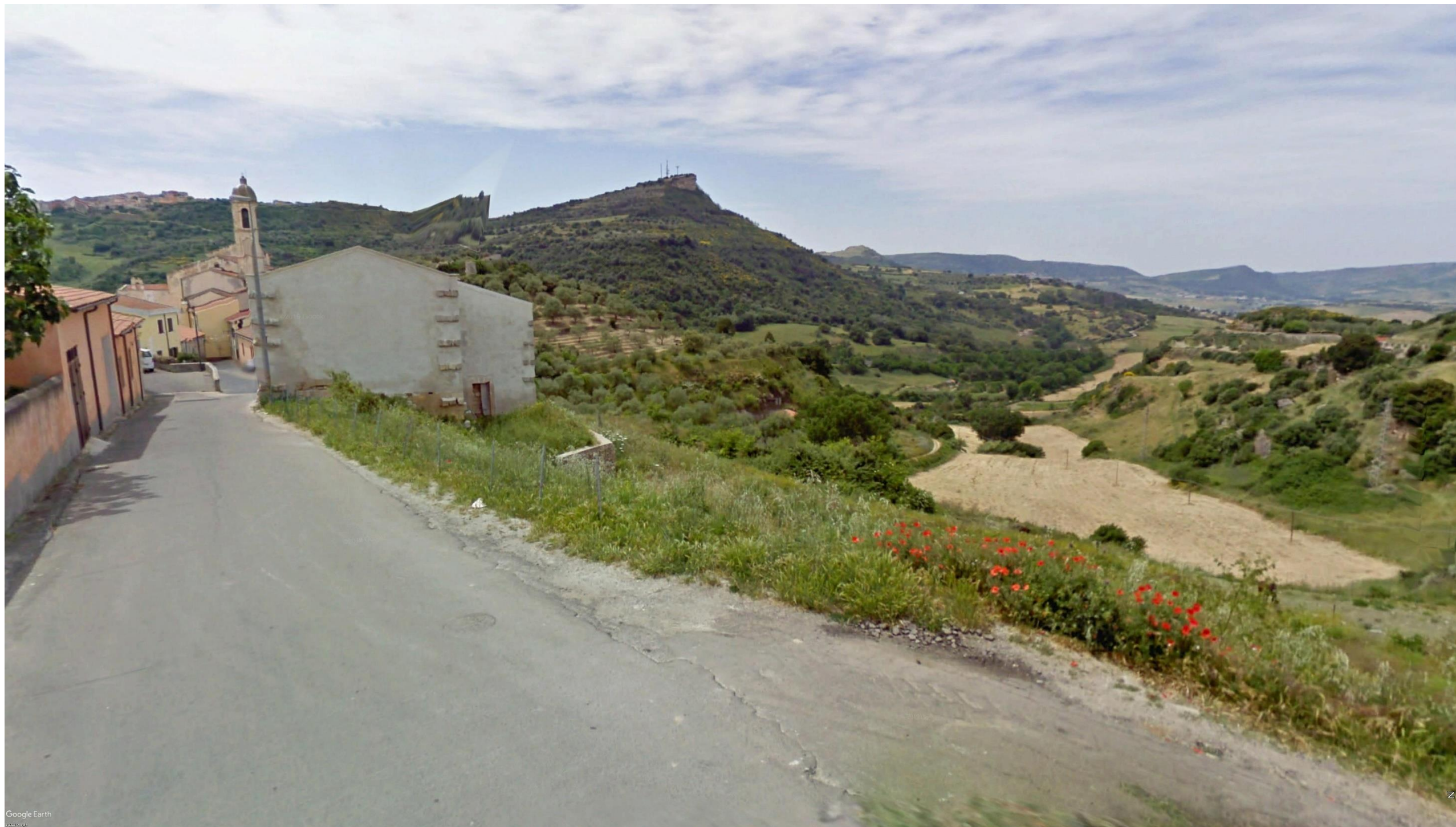
Punto 8: Progressiva 2+680.00: Vista da Via Don B. Solinas, traversa di Via Sassari, in direzione nord-ovest. Il punto di ripresa è in prossimità dell'area di notevole interesse pubblico (art. 136 D.Lgs. 42/04) denominata "Zona Sita nel Comune di Codrongianos situata in un complesso avente valore estetico e tradizionale per la bellezza panoramica e per la presenza dell'abbazia di Saccargia." È visibile, in primo piano sulla sinistra, il vincolo storico-architettonico-culturale "Ex Chiesa-Oratorio del SS. Rosario" tutelato dall' ex art.136 del D.Lgs. 42/2004 "Immobili ed aree di notevole interesse pubblico sottoposte a vincolo paesaggistico". L'immagine mostra la campagna con diversi rilievi altimetrici e con la presenza di "praterie" e "colture specializzate e arboree" come individuate da PPR. (fonte: Google Earth)
