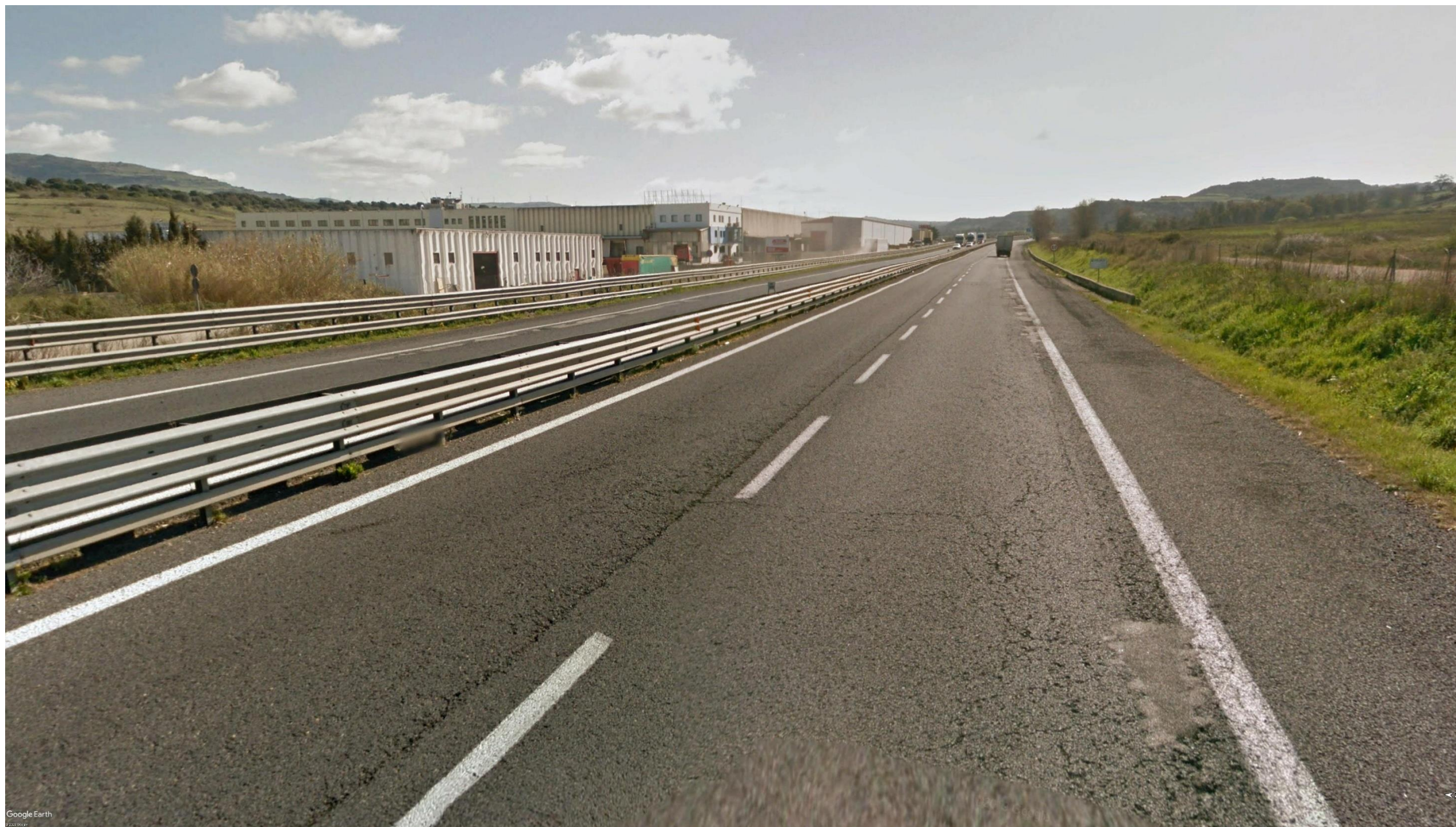
Punto 16: Progressiva 5+710.00. Vista dalla Strada Statale 131 "Carlo Felice" in direzione est. Consiste nel tratto finale dell'intervento oggetto di studio nella cui prossimità insiste un'area caratterizzata secondo PPR da "colture erbacee specializzate, aree agoforestali, aree incolte". La foto mostra la statale oggetto di studio e sulla sinistra è riconoscibile la Zona Industriale Padriggia.
