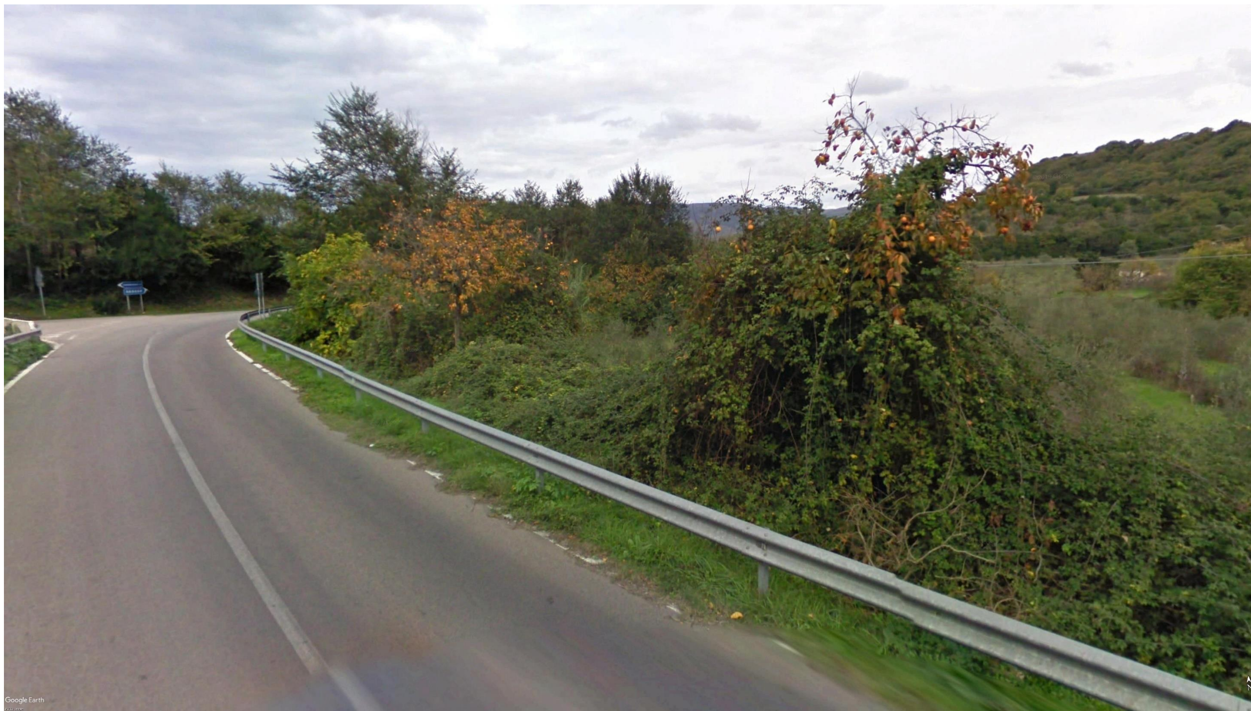
Punto 13: Progressiva 3+820.00. Vista dalla Strada Provinciale SP 26 in direzione dell'incrocio con la Strada Provinciale SP 152. Nell'area inquadrata in foto, risulta visibile l'asse stradale, al di sotto del quale passa perpendicolarmente il corso d'acqua Riu Pedra Nedda, vincolato dal PPR ai sensi dell'art.143 del D.Lgs.42/04. L'immagine mostra inoltre una fitta vegetazione costituita da "colture erbacee specializzate, aree agroforestali, aree incolte", come definita da PPR. La foto è presa in prossimità dell'area di notevole interesse pubblico (art. 136 D.Lgs. 42/04) denominata "Zona Sita nel Comune di Codrongianos situata in un complesso avente valore estetico e tradizionale per la bellezza panoramica e per la presenza dell'abbazia di Saccargia." (fonte: Google Earth)
