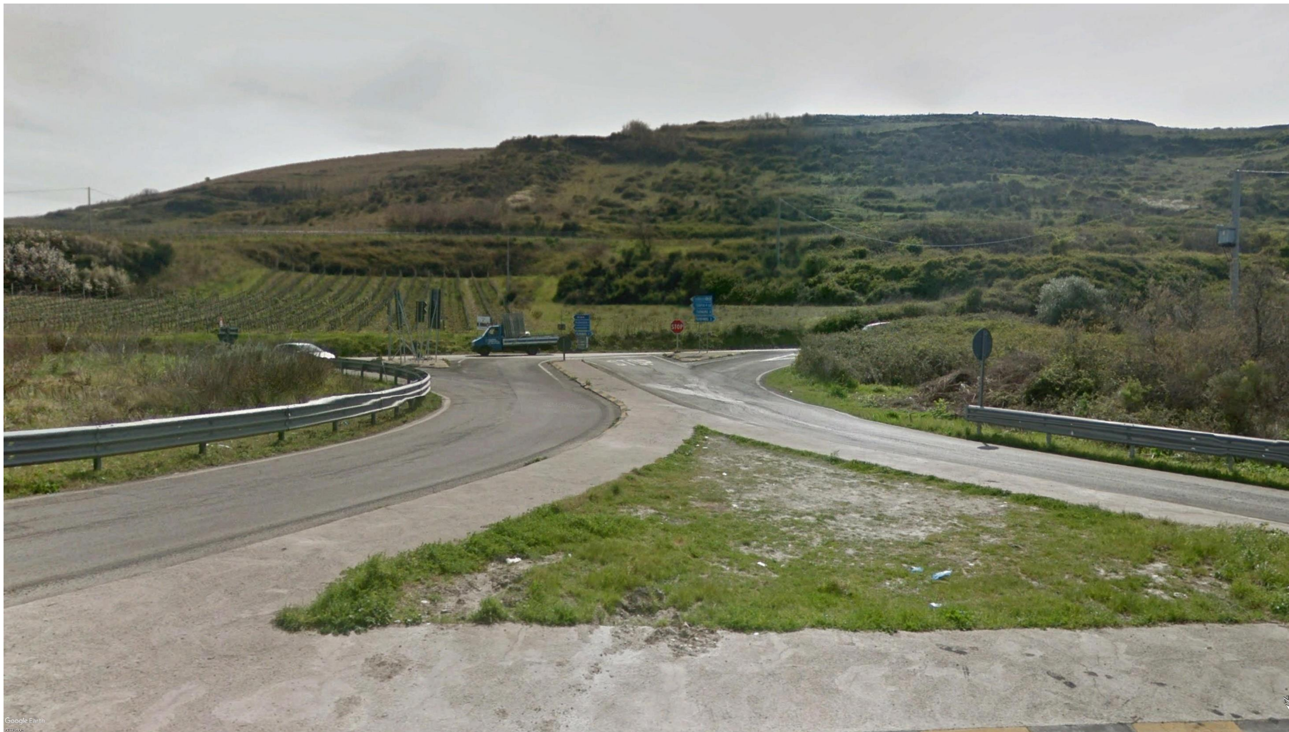
Punto 4: Progressiva 1+420.00. Vista dalla Strada Statale 131 "Carlo Felice" in direzione dello svincolo con la Strada Provinciale SP3. Sullo sfondo è percepibile un paesaggio caratterizzato da "praterie" e "colture erbacee specializzate", come definiti da PRR , mentre in primo piano è visibile l'isola stradale che separa le strade.(fonte: Google Earth)
