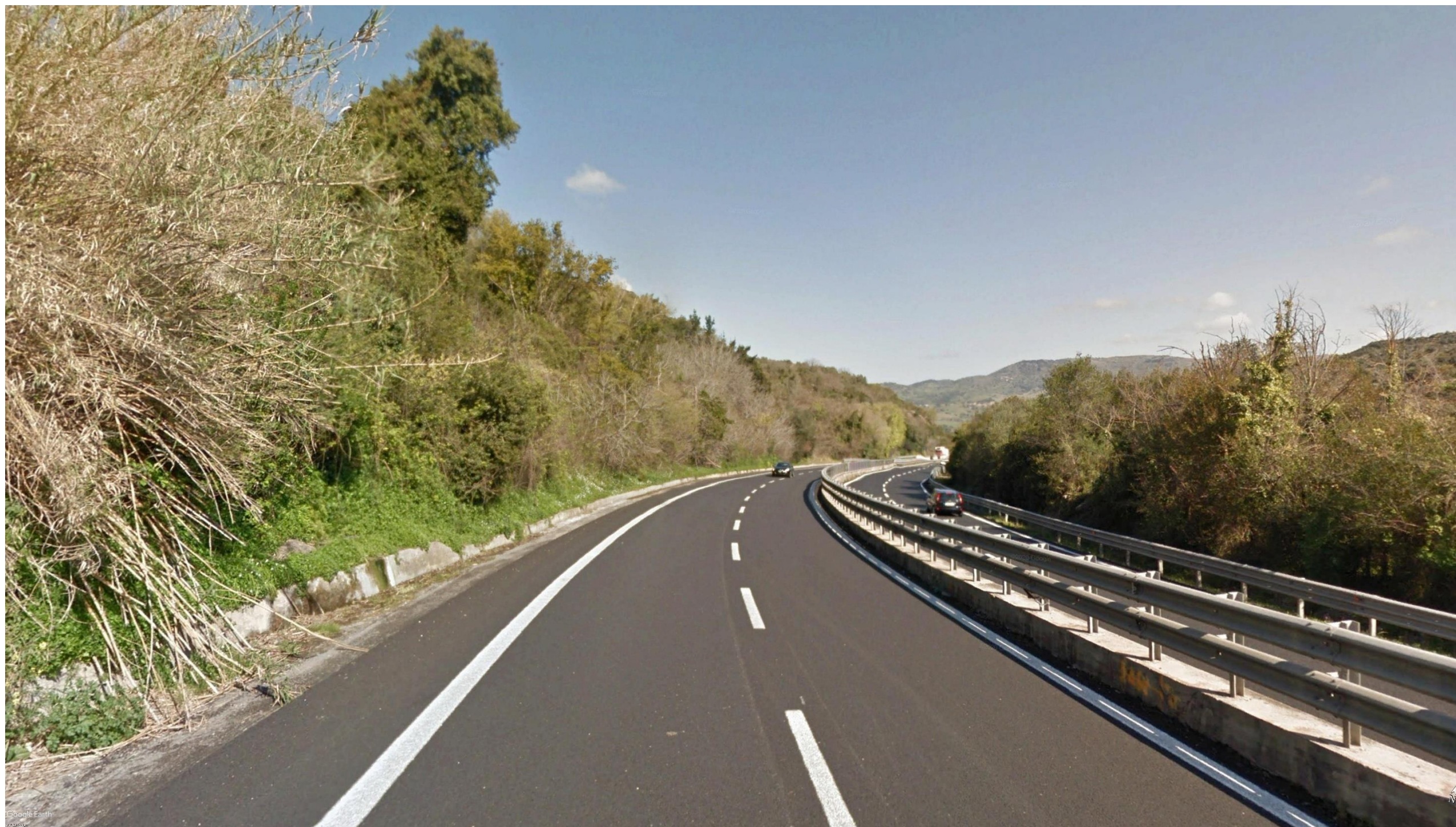
Punto 7: Progressiva 2+630.00. Vista dalla Strada Statale 131 "Carlo Felice" in direzione nord. Nell'area inquadrata in foto, risulta visibile l'asse oggetto di intervento in prossimità di una vegetazione caratterizzata da un'area boschiva con presenza di alberature fitte(fonte: Google Earth).
