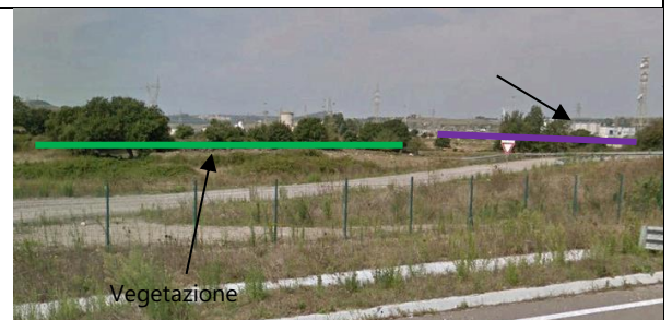
Vista da SS597, in direzione dell'asse stradale principale al km 0+500 circa. La visuale del tracciato è ostacolata dalla presenza di vegetazione ed elementi dell'edificato.
