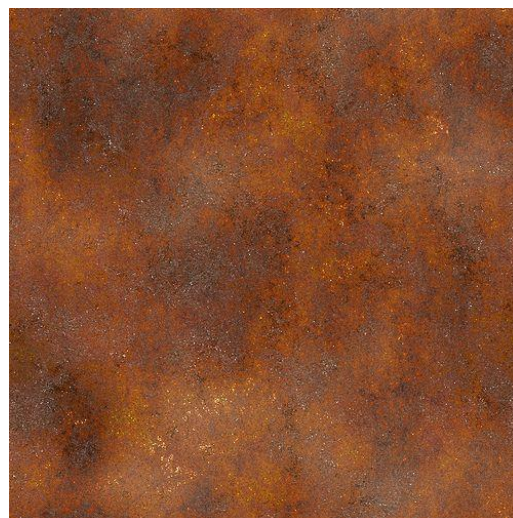
Acciaio COR-TEN – velette viadotto
