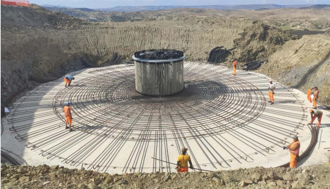
**Figura a-3: immagine tipo posa anchor cages**
