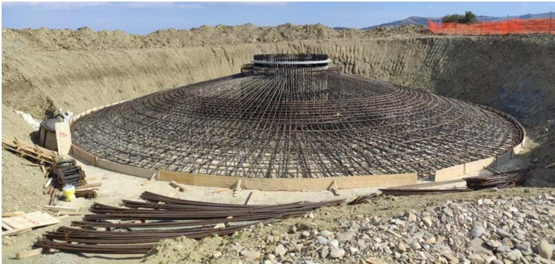
**Figura a-4: immagine tipo armature plinto**
