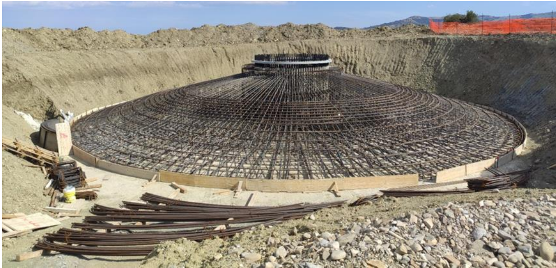
Figura 4-4: immagine tipo armature plinto
