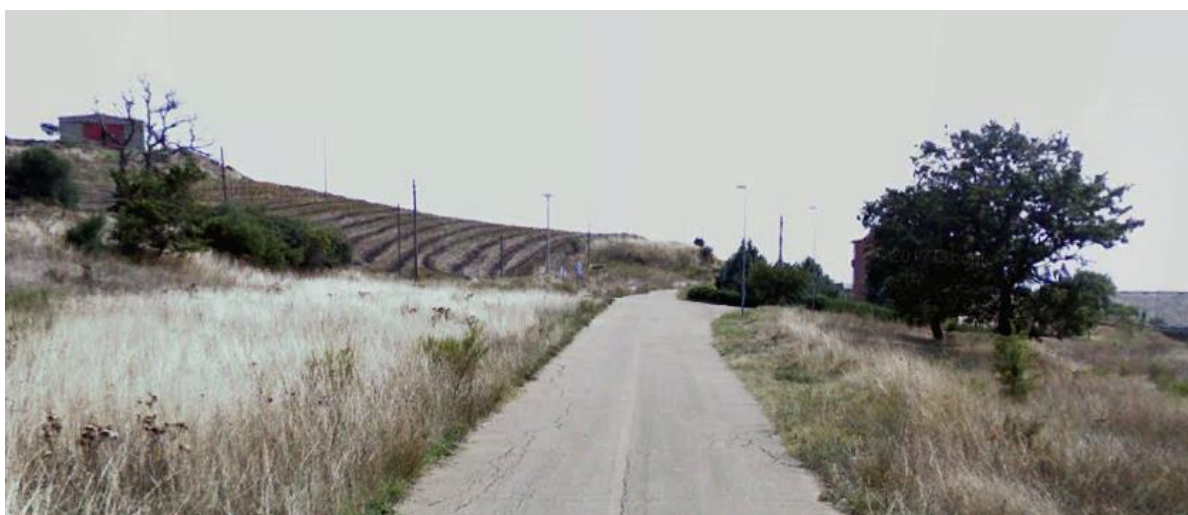
Figura b-4: Viabilità locale nei pressi della WTG1
