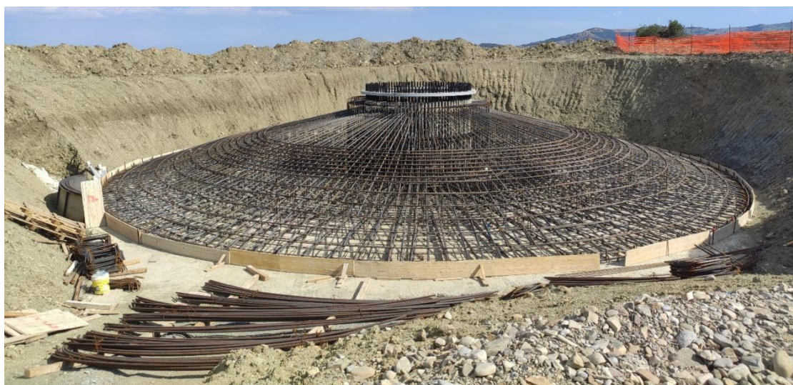
Figura 7: armatura plinto tipo
