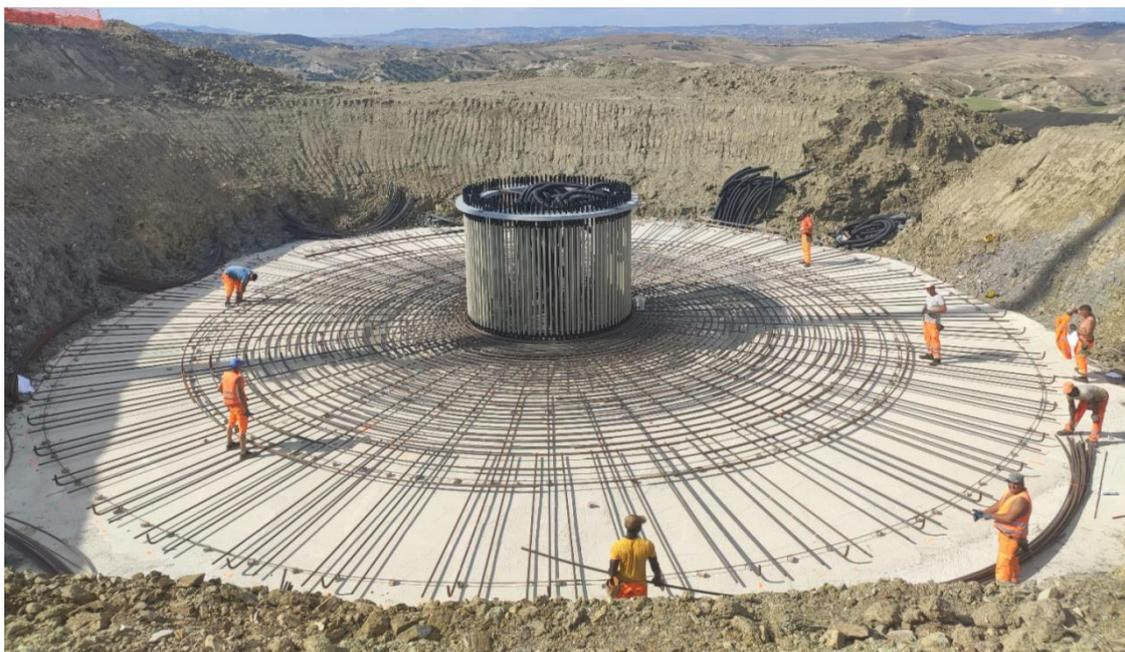
**Figura 5-4: immagine tipo posa anchor cages**
