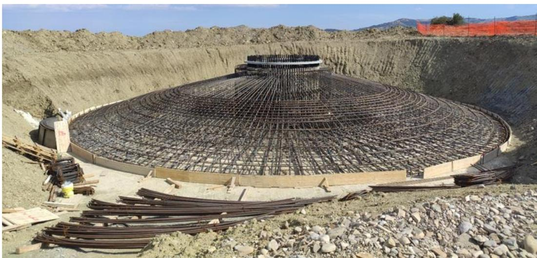
**Figura 5-5: immagine tipo armature plinto**
