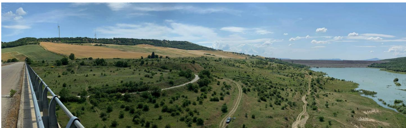
Figura 3-31: Panoramica ante operam
