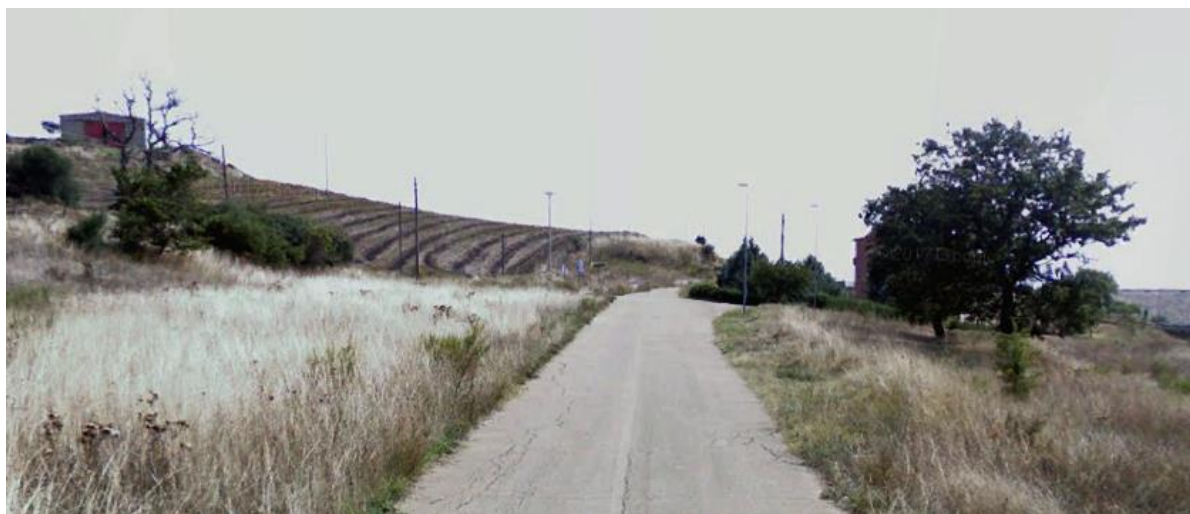
Figura 3-43: Viabilità locale nei pressi nella WTG1
