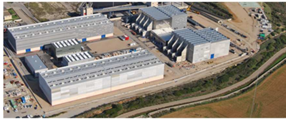
Figura 1 - Foto aerea dell'impianto SAPEI, confinante con la Centrale di Fiume Santo
