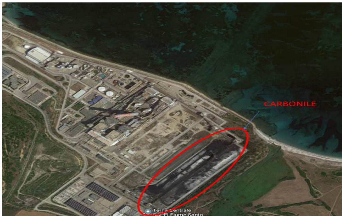
Figura 2 - Vista dall'alto della Centrale di fiume Santo con evidenziazione del carbonile
