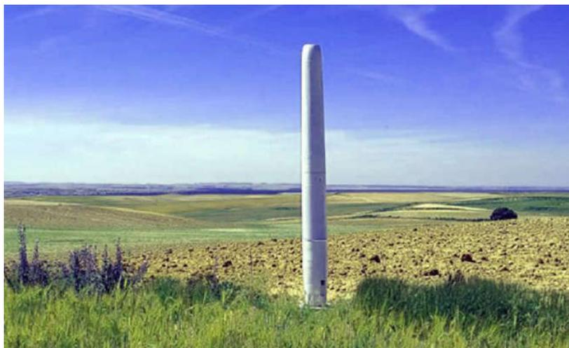
Impianto energetico che sfrutta il fenomeno della **risonanza aeroelastica**, che produce delle vibrazioni attraverso l'oscillazione (creando una serie di vortici, la cosiddetta scia vorticoso di Von Kármán). È sfruttando queste ultime che è possibile ricavare energia.
